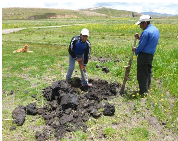
Figura 5: Apertura de calicatas
