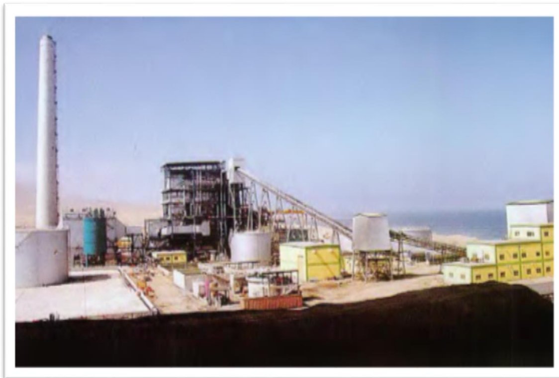
Figura 12 Vista General de la Central Termoeléctrica ILO21
