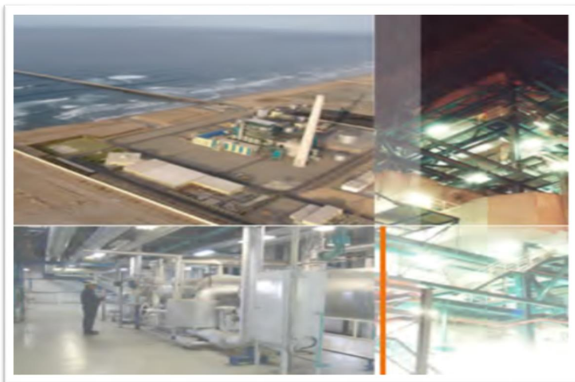
Figura 13 Vista Interior de las Instalaciones de Central Termoeléctrica ILO2
