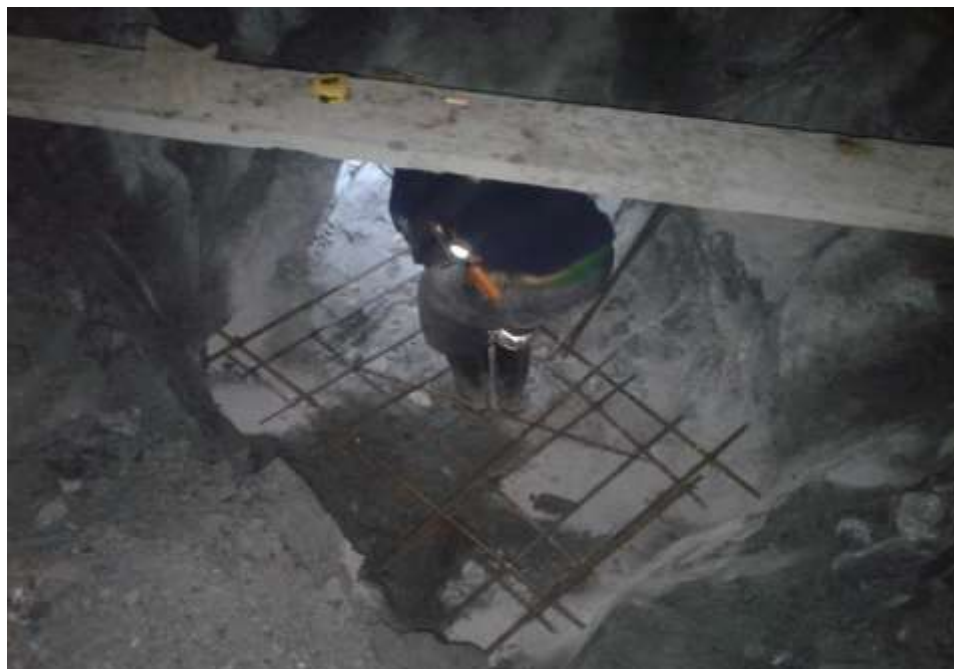
Foto 6. Construcción de zapata para anclaje del winche Fuente: Minera la Española S.A.
