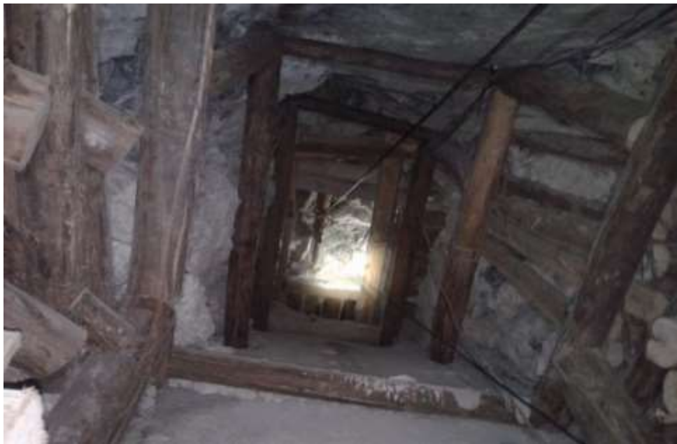
Foto 9. Cámara de izaje del pique 01 Fuente: Minera la Española S.A.
