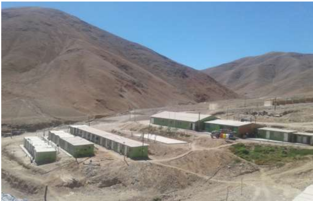
Foto 11. Campamento minero Minera la Española S.A. Fuente: Minera la Española S.A.
