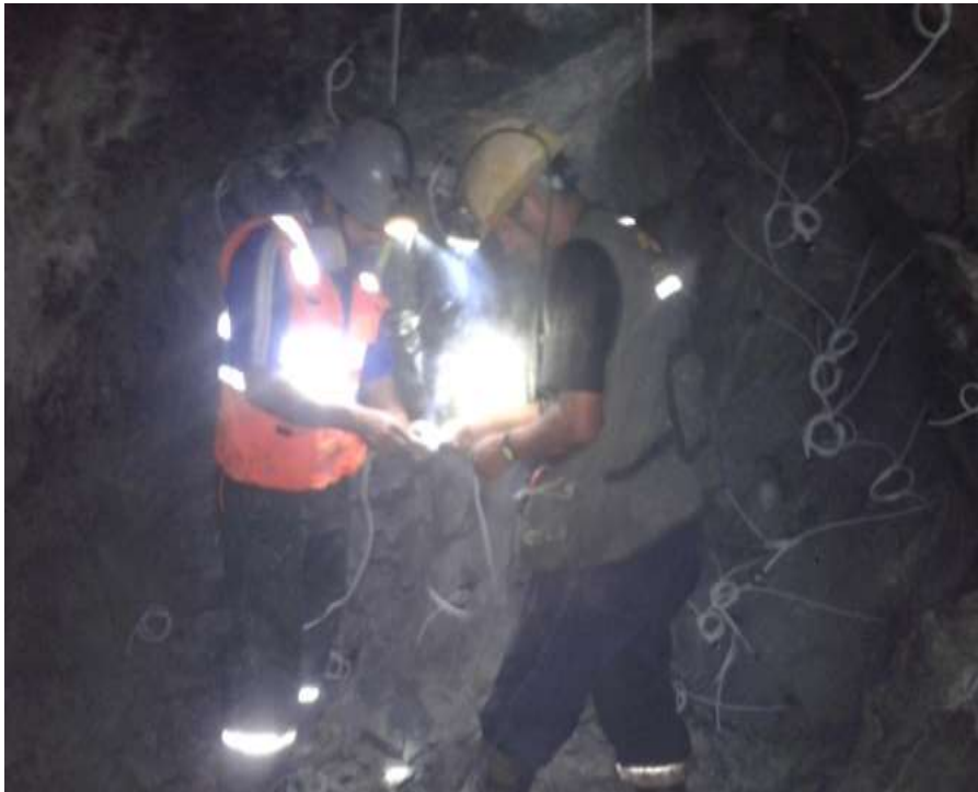
Figura 14. Perforación y voladura de la cámara de izaje Fuente: Minera la Eghspañola S.A.
