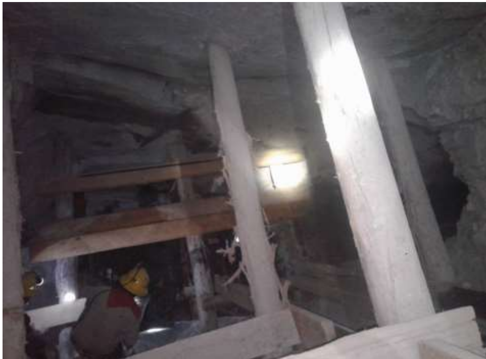
Foto 5. Profundización del Pique Inclinado 90 Fuente: Minera la Española S.A.
