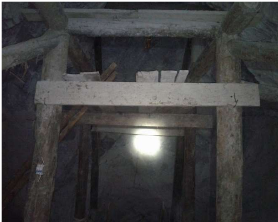
Figura 15. Construcción de castillete Fuente: Minera la Española S.A.
