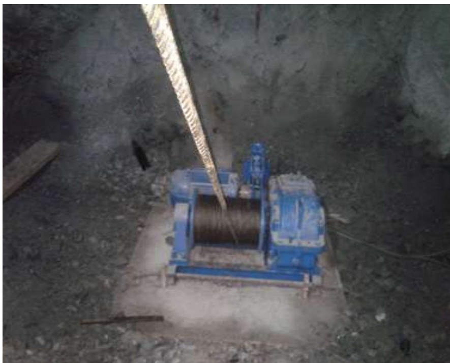
Figura 17. Winche de izaje de 15 HP Fuente: Minera la Española S.A.
