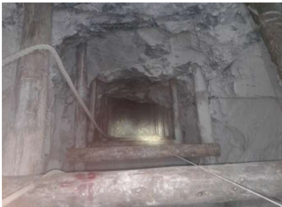
Figura 21. Instalación de guideras de madera Fuente: Toma de imagen propia (2017)
