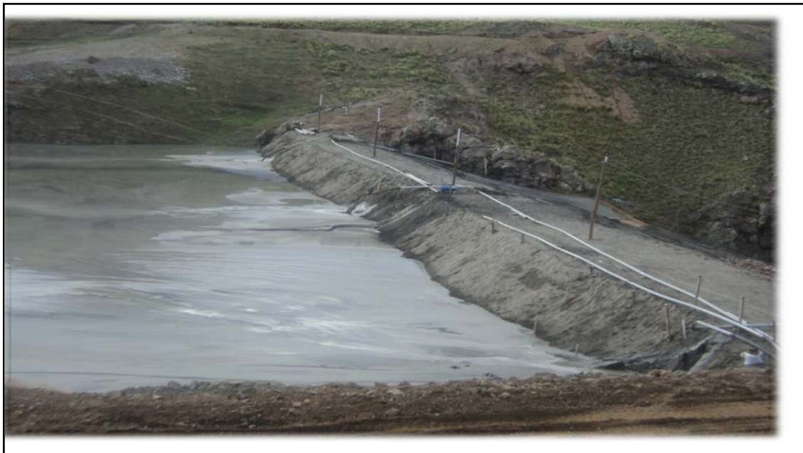
Figura N° 1. Planta concentradora Santa Lucia. Fuente. Autor de tesis.
