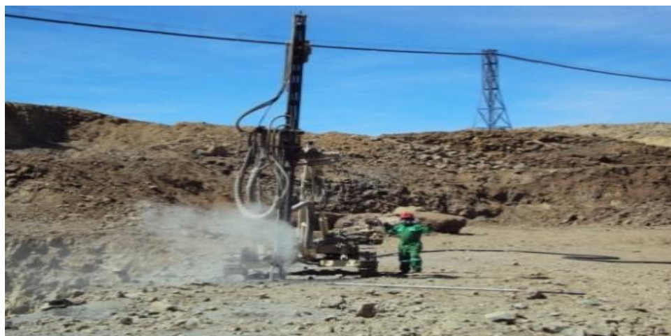
Figura 4.18. Perforadora track drill Ingersoll Rand Fuente.Unidad Minera Tacaza - CIEMSA
