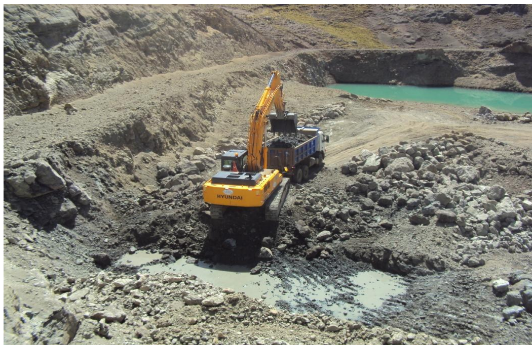
Figura 4.16. Excavadora hidráulica. Fuente.Unidad Minera acaza-CIEMSA
