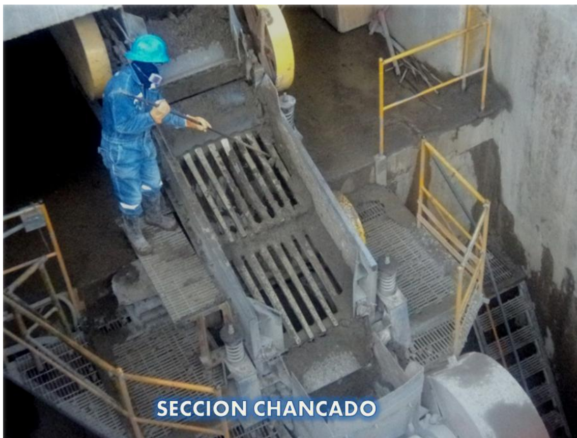
Figura N° 2. Planta concentradora Santa Lucia. Fuente. Autor de tesis.
