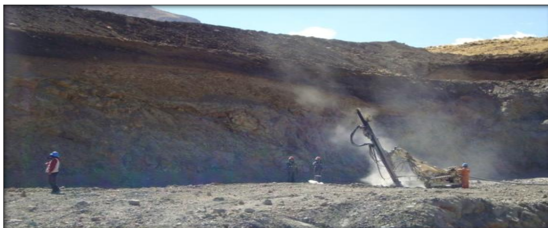
Figura 4.2. Perforadora track drill en operación. Fuente. Unidad Minera Tacaza
