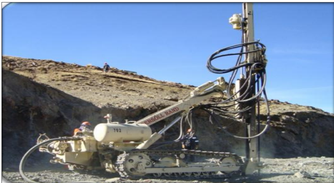
Figura 4.1. Perforadora track drill Fuente. Unidad Minera Tacaza
