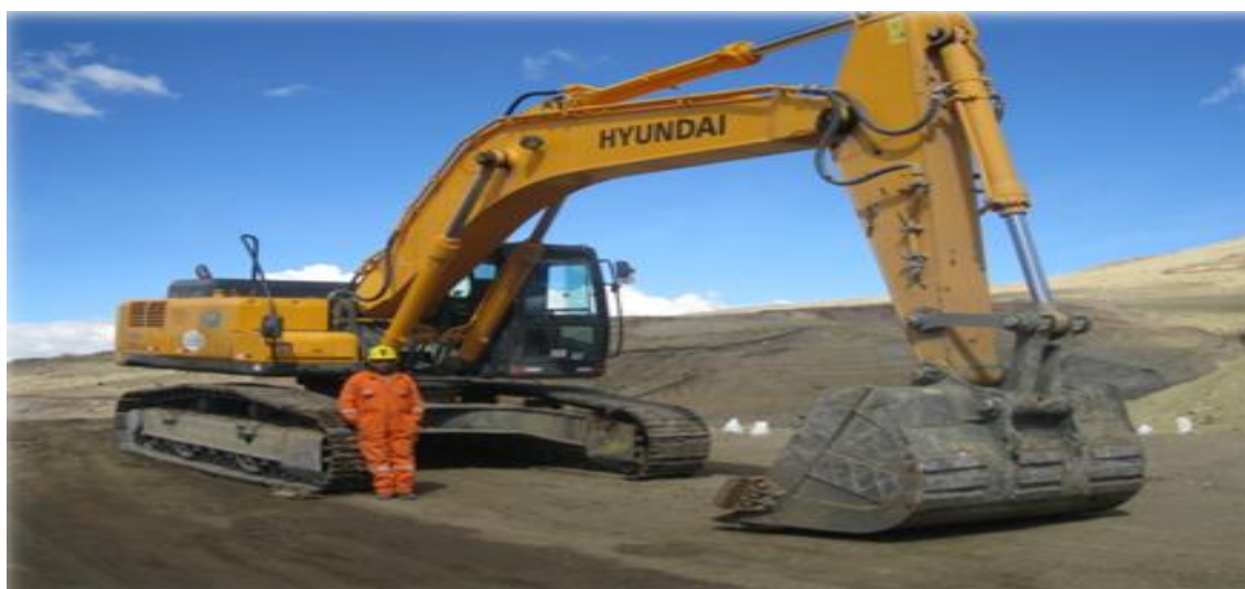
Figura 4.19. Excavadora hidráulica Hyundai 360 lc-7A . Fuente. Unidad Minera Tacaza - CIEMSA
