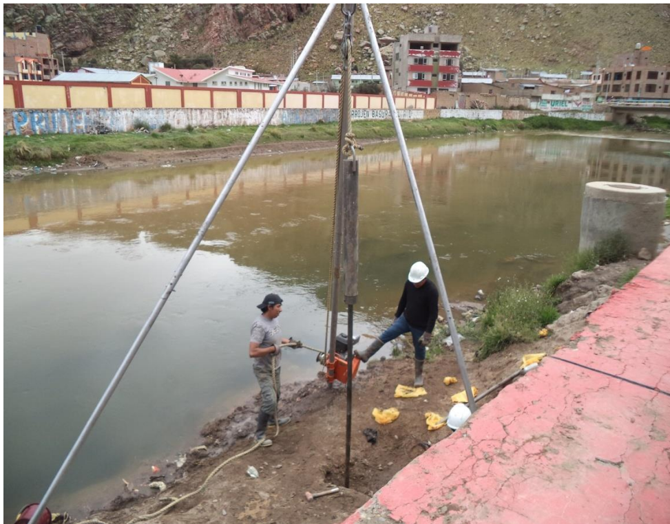
IMAGEN 12: Exploración con SPT en Estribo de la margen izquierda de río.
