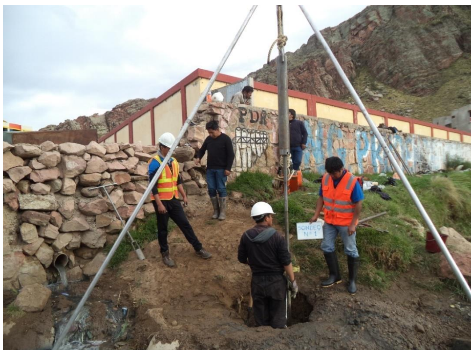
IMAGEN 10: Exploración con SPT en Estribo de la margen derecha de río.
