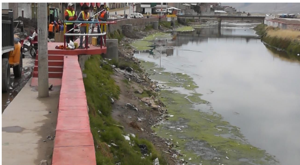
IMAGEN 4: Vista de instalación de equipo en primera estación para iniciar levantamiento topográfico.
