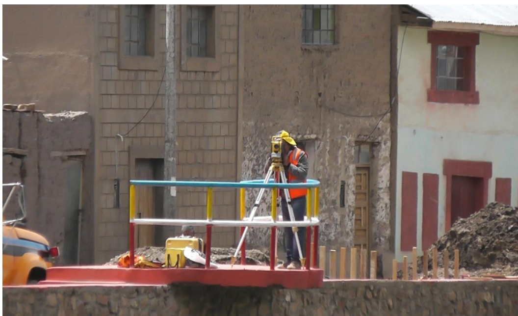
IMAGEN 7: Ubicación de estación total en zona con bastante visibilidad.
