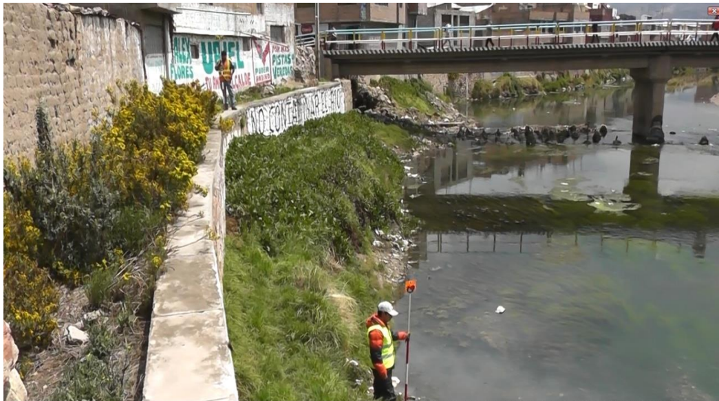
IMAGEN 8: Ubicación de prismas en zona de puente construido aguas abajo de proyecto.
