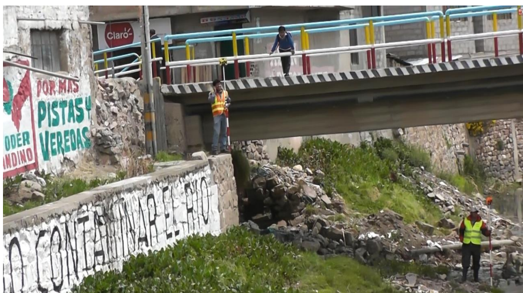
IMAGEN 5: Ubicación de prismas en zona de puente construido aguas abajo de proyecto.,
