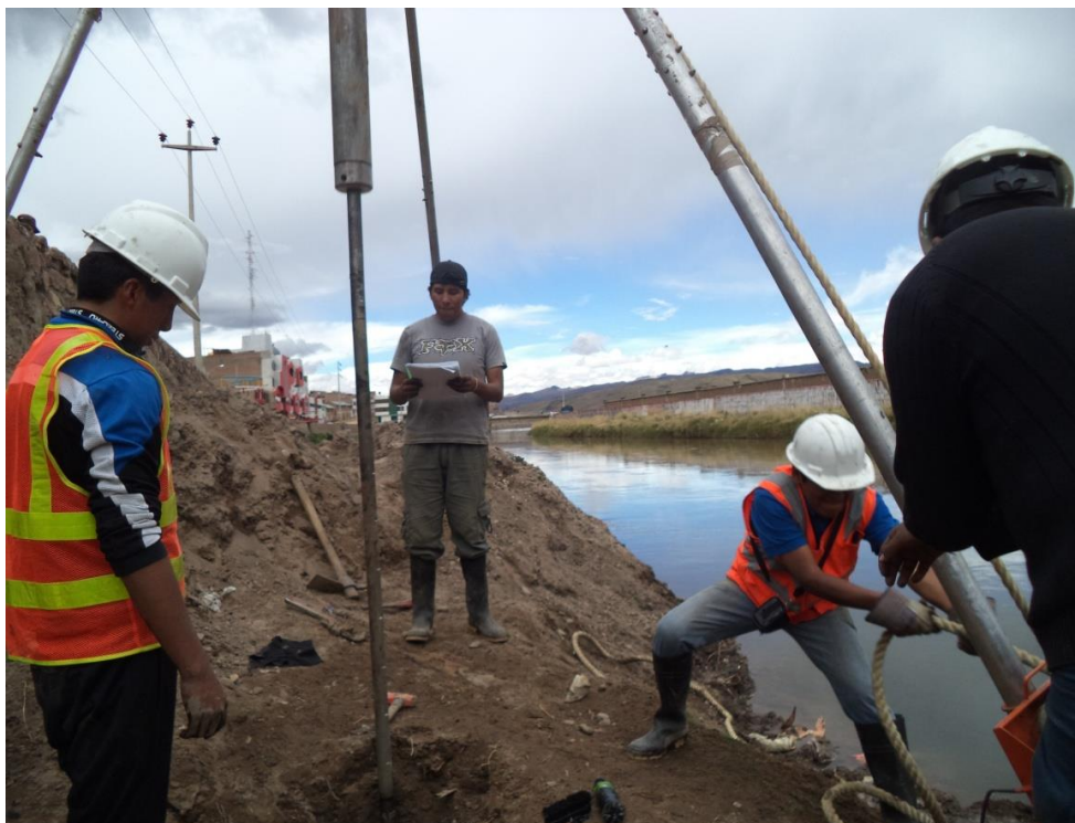
IMAGEN 13: Imagen que muestra desarrollo de Trabajo y toma de datos de SPT.
