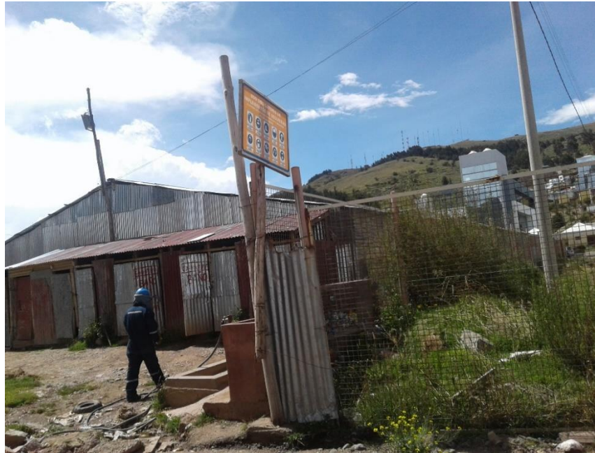
Figura 15. Incumplimiento con la NTP 399.010 Señales de Seguridad.
