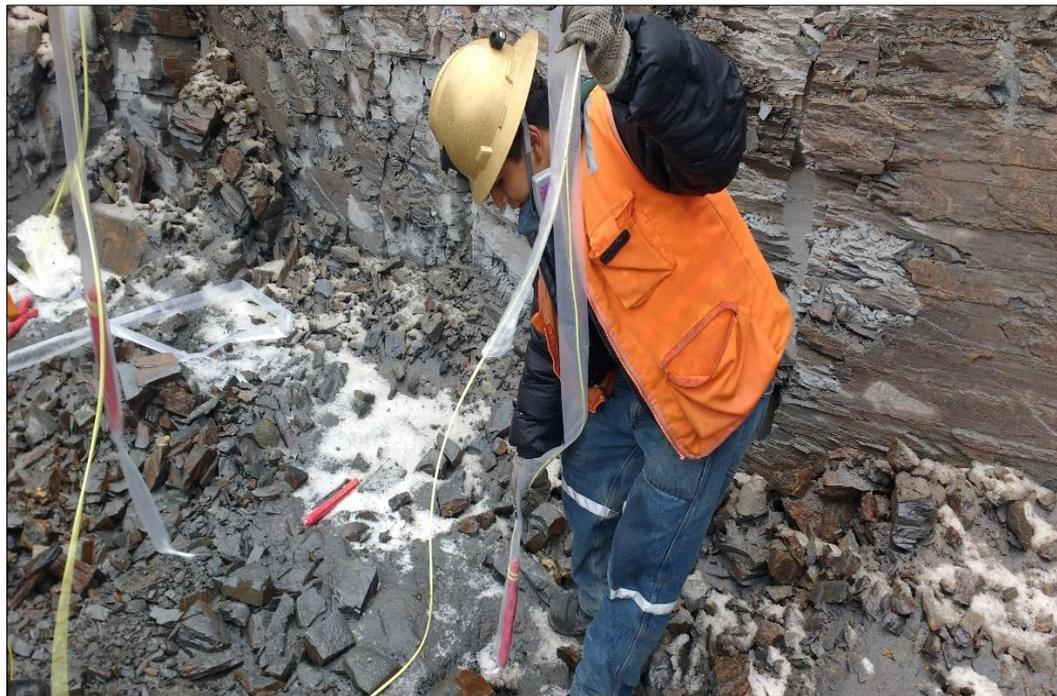
Foto 7: Carguío de taladros de pre-corte acorde al diseño.
