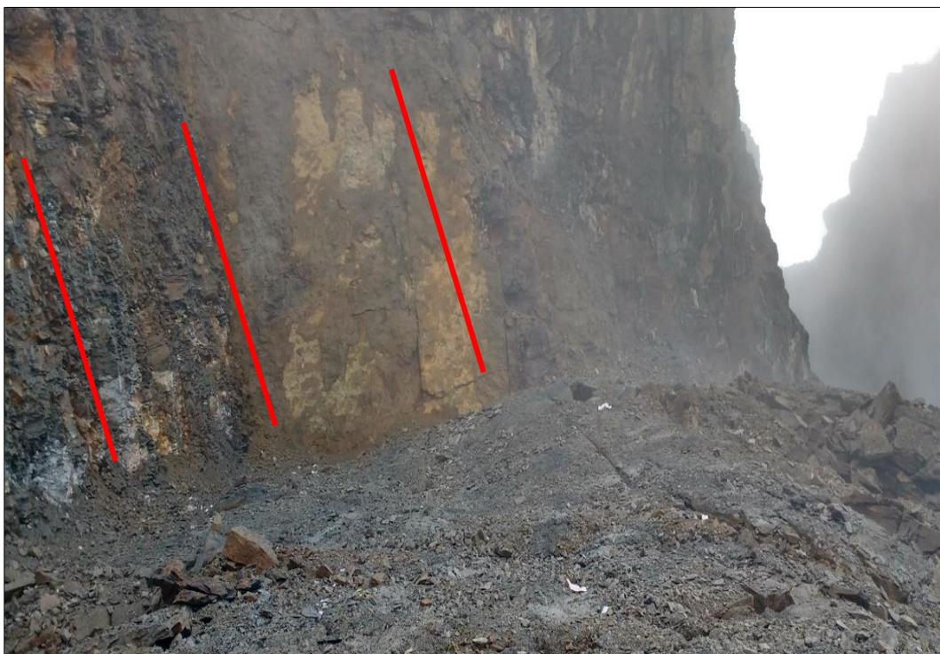
Foto 4: Resultado de la voladura de pre-corte (Talud estable).
