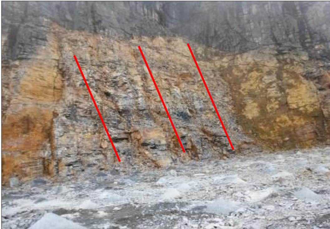
Foto 3: Resultado de la voladura de pre-corte acorde al proyecto de investigación.
