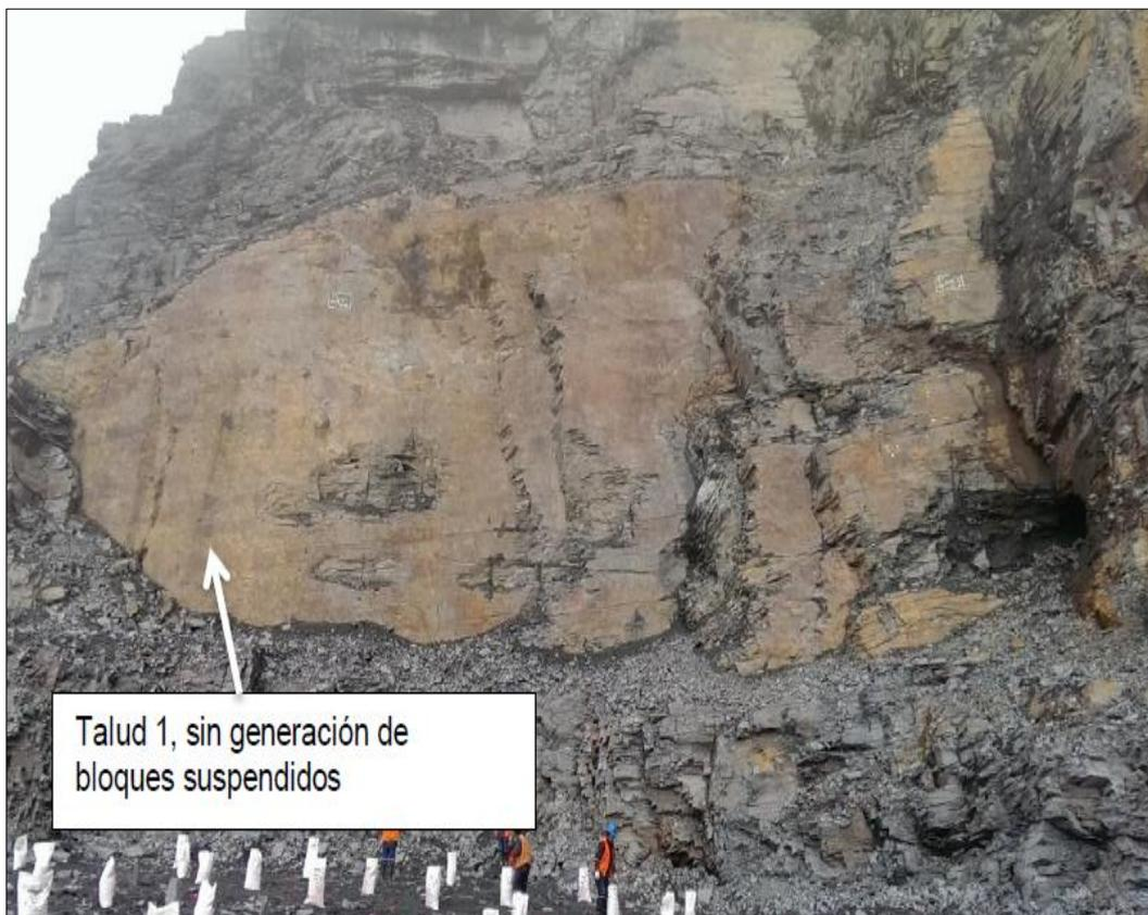
Foto 5: Talud uno la explotación es de acuerdo al comportamiento estructural.
