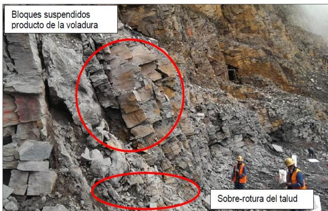
Foto 2: Bloque suspendido y sobre-rotura en la base del talud final.
