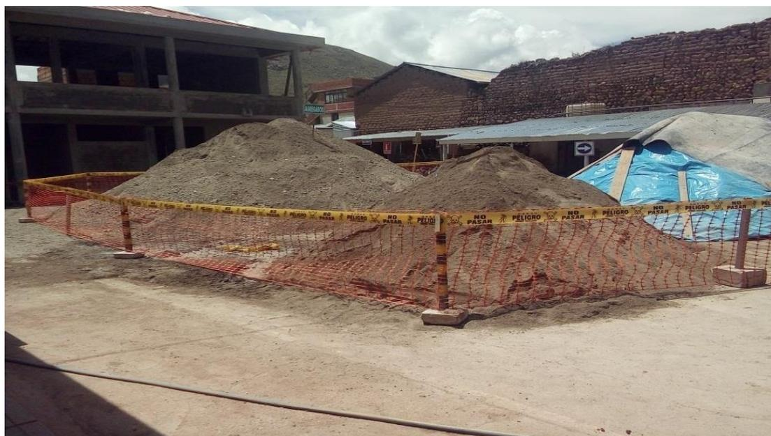
Figura N° 14.- Implementación de señalización en obra
