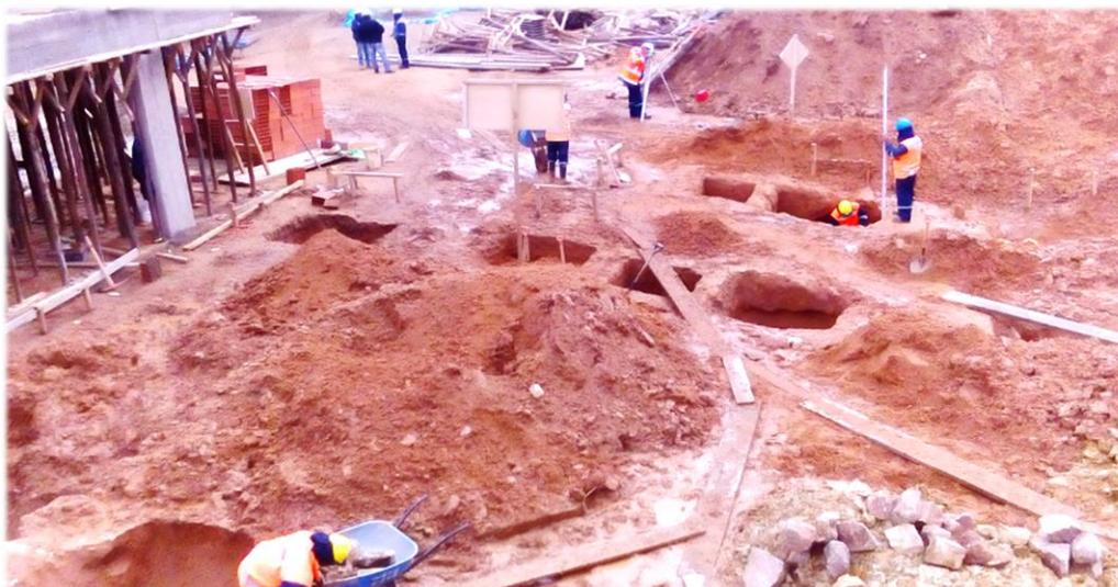
Figura N° 8.- Actividades de excavación- falta la estandarización del área
