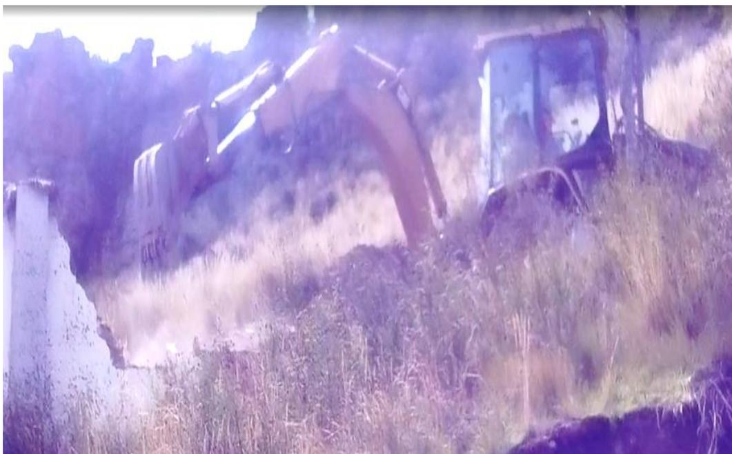
*Figura N° 10.- Demolición de cerco perimétrico con maquinaria*
