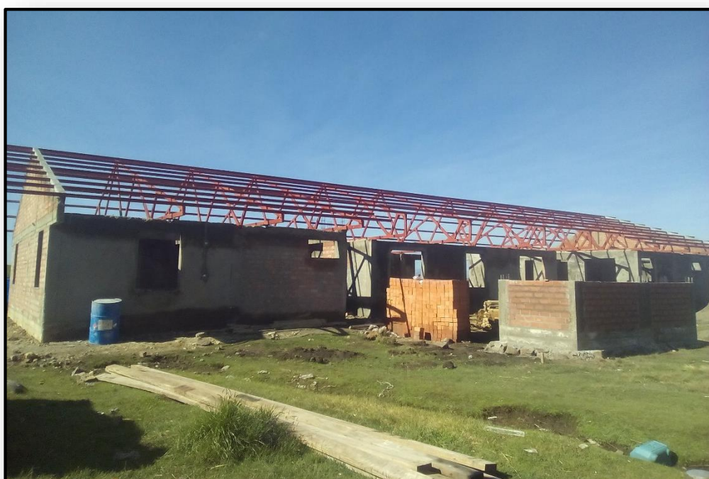
Figura N° 33. Estado del saldo de proyecto en recepción Fuente: Cámara fotográfica de obra
