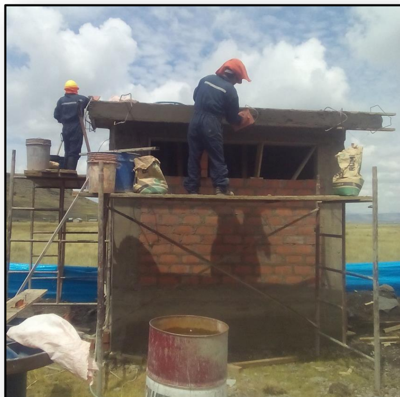
Figura N° 36. Columnas pertenecientes a la caseta de bombeo Fuente: Cámara fotográfica de obra
