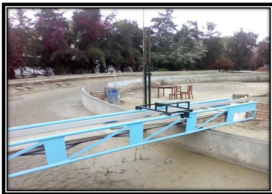
Figura 138: Puente metálico con silla movable. Fuente: Elaboración Propia.
