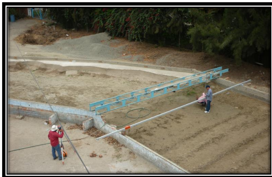
Figura 65: Colocación de tarugos a una determinada cota. Fuente: Elaboración Propia.
