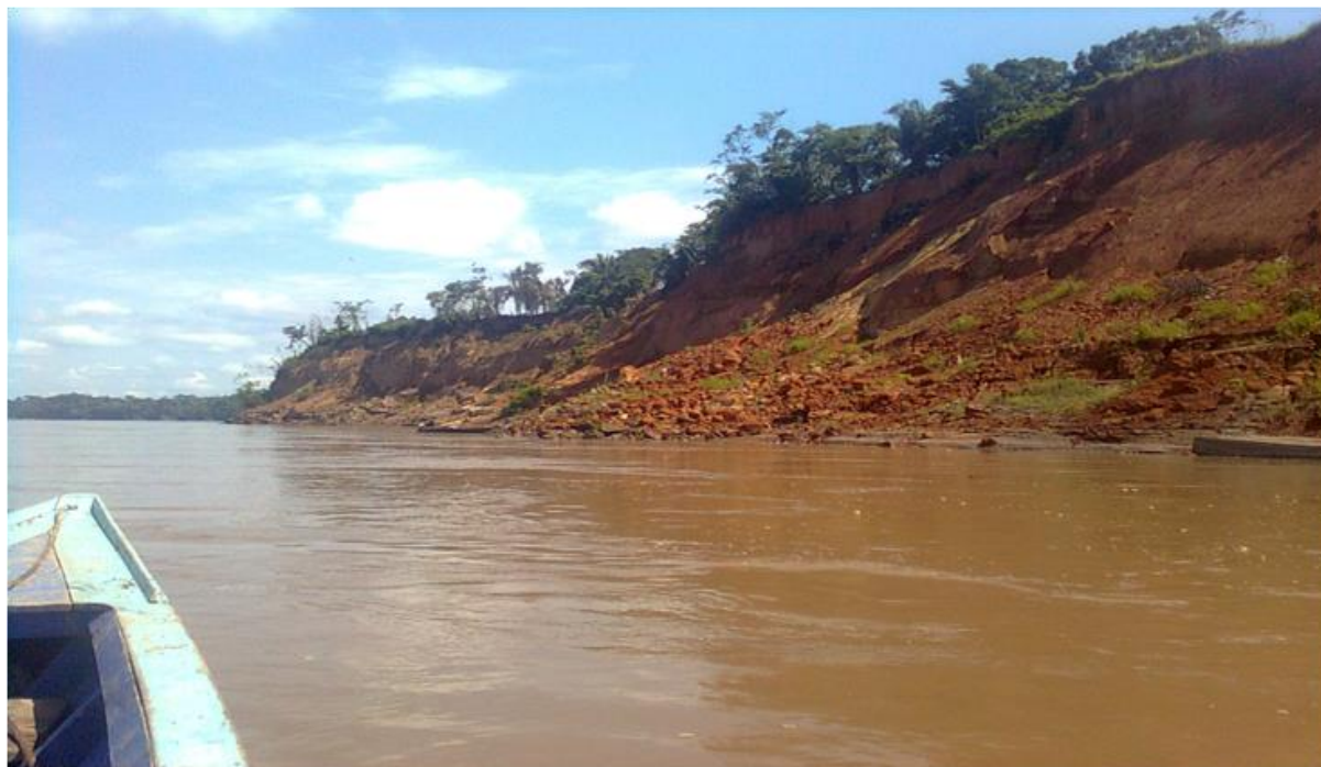
Fotografía Nº 2 Vista del talud en la zona de La Pastora, donde se aprecian derrumbes de material no consolidado y paredes verticales en la parte alta. La falta de vegetación es una constante en este sector.
