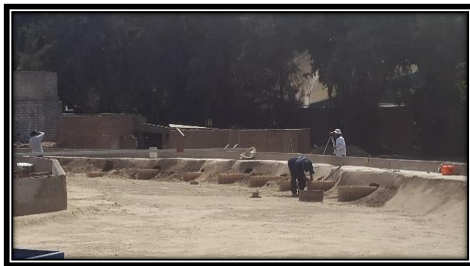
Figura 68: Colocación de los espigones ELJ en el lado cóncavo del canal experimental. Fuente: Elaboración Propia.
