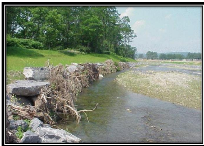
Figura 30: Protección con fajo de raíces.
