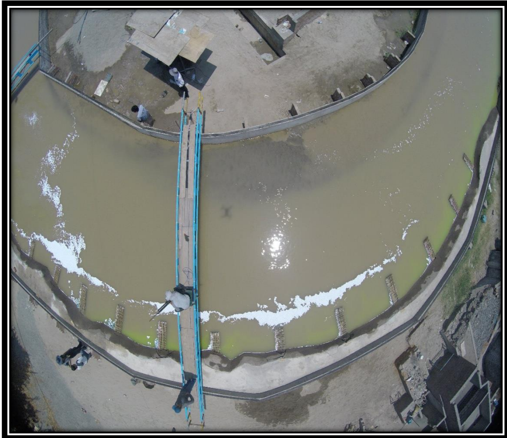
Figura 146: Colocación de tecnopor. Fuente: Elaboración Propia.
