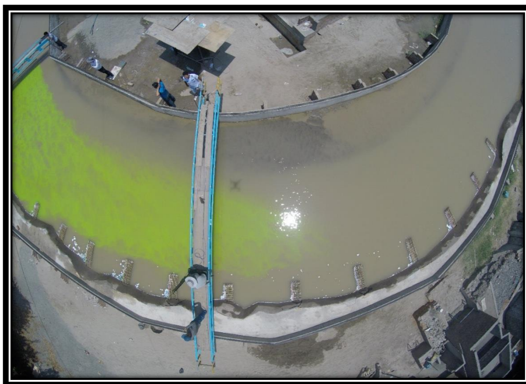
Figura 145: Vista aérea de la fluoresceína para ver la dirección del flujo. Fuente: Elaboración Propia.
