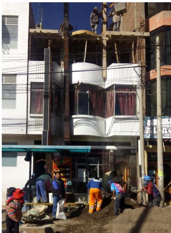
Figura 45. Elaboración del concreto en losas de techos de vivienda autoconstruida.
