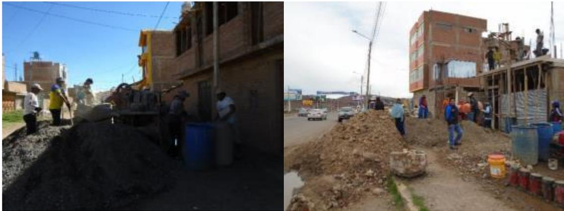
*Figura 36. Agregado utilizado para el vaciado de losas de viviendas*
