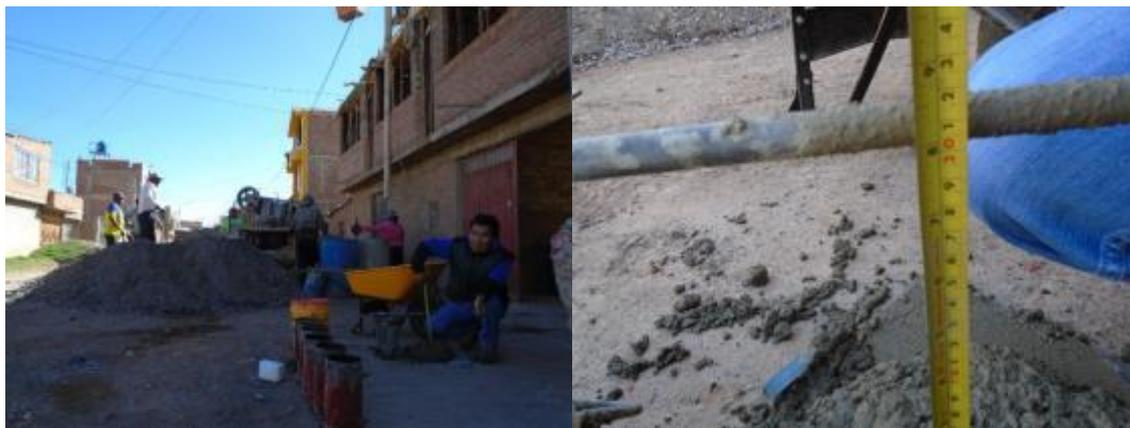
*Figura 38. Asentamiento observado en vivienda con un concreto cohesivo y homogéneo y Slump = 8"*
