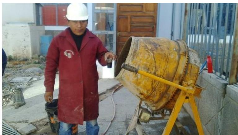
*Figura 26. Dosificación de materiales por peso*
