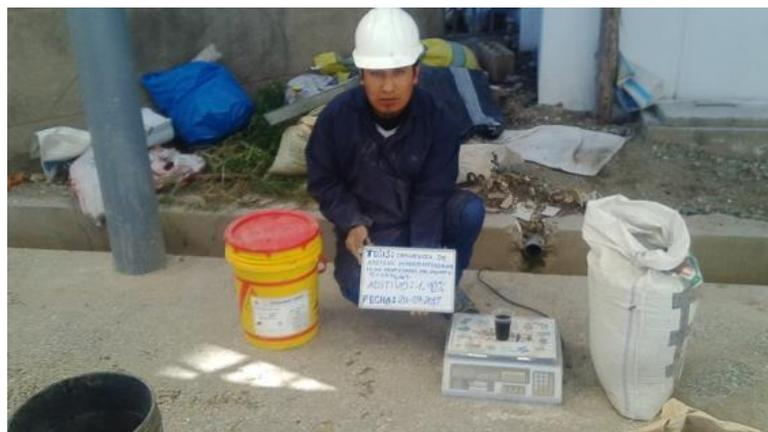
*Figura 25. Dosificación de materiales por peso*
