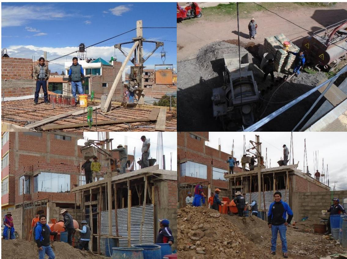
Figura 41. Mezcladora de Concreto - Winche Eléctrico
