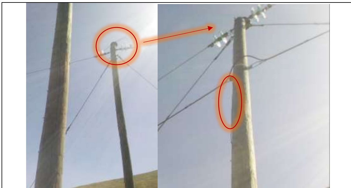
El aislador está en pésima condición, Un conductor de bajada está colgado en el aire y el resto no están aterrados a tierra.
