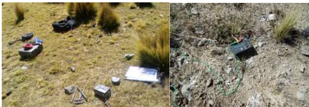
Figura Nº 4.6: Imágenes de la medición de resistencia de puesta a tierra
