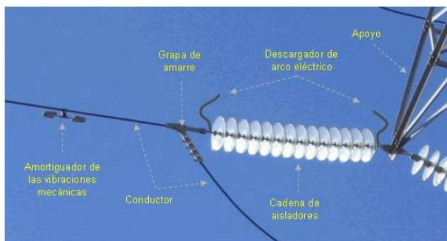
Figura N° 2.15: Aislador en cadena
