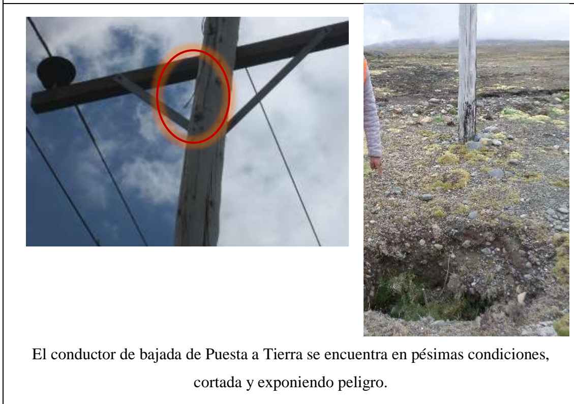
El aislador está en pésima condición, Un conductor de bajada está colgado en el aire y el resto no están aterrados a tierra.
