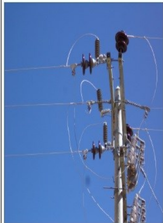
Instalación de pararrayos de línea.
