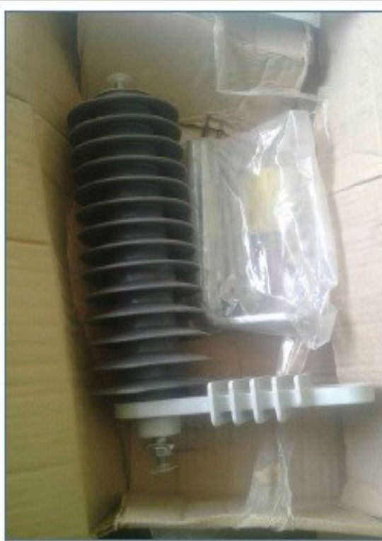
Cambio de pararrayo de línea.
