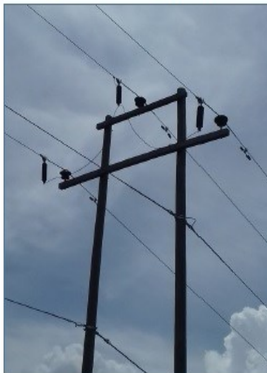
Instalación de pararrayos de línea.
