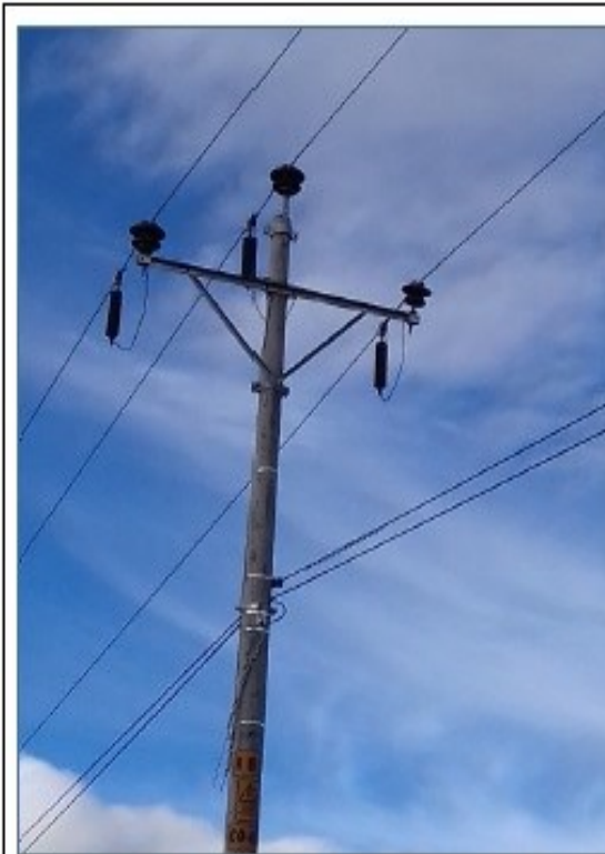
Instalación de pararrayos de línea.
