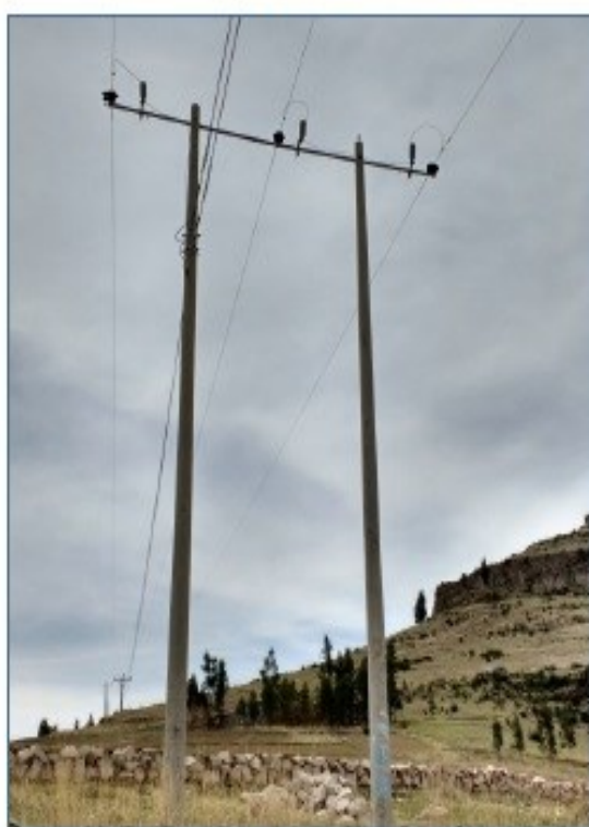
Cambio de pararrayo de línea.
