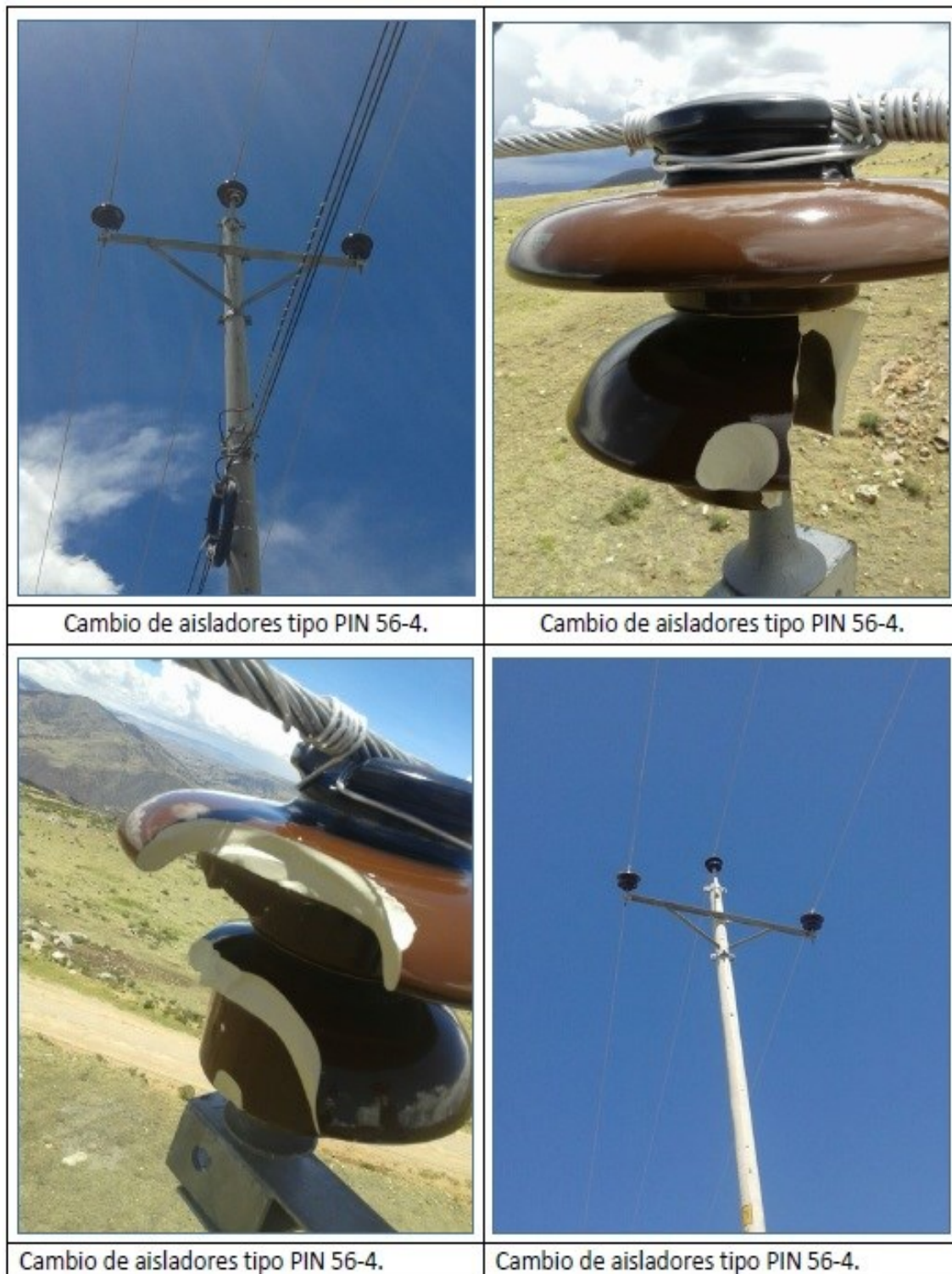
FIGURA F.1: Cambio de aisladores alimentador LL-02.
