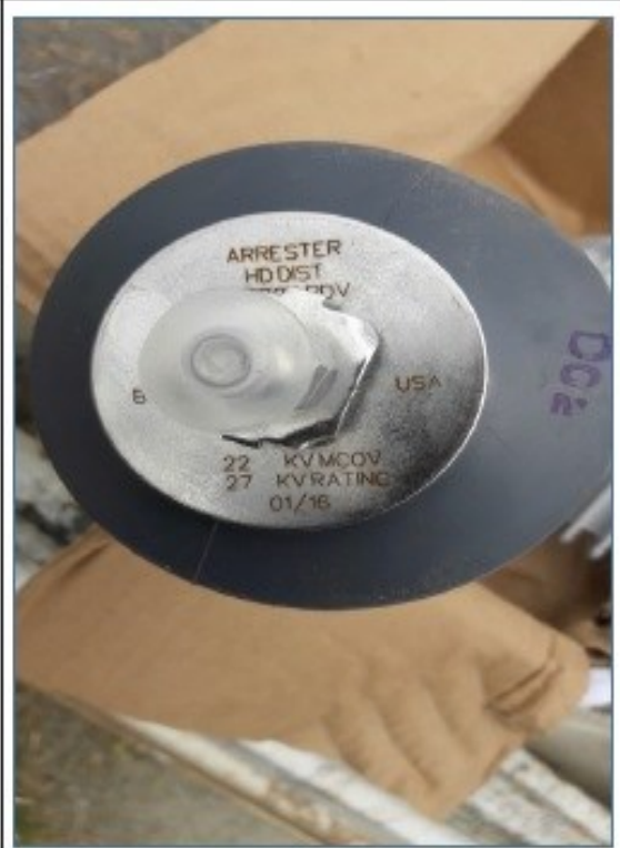
Cambio de pararrayo de línea.
