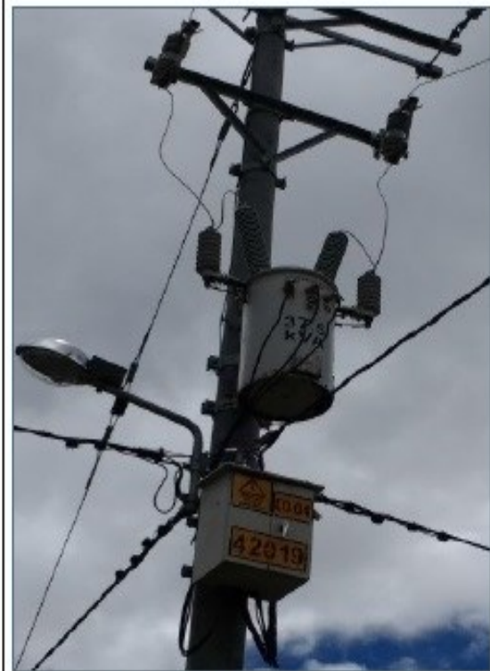
Instalación de pararrayos en subestación.
