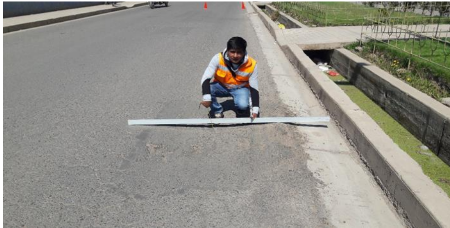
Figura 2. 7.Falla Hundimiento, Avenida Tacna, (Fuente: Elaboración Propia)
