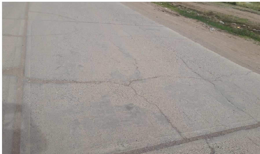
Figura 2. 20.Falla losas subdivididas, Av. circunvalación José Ignacio Miranda (Fuente: Elaboración propia)
