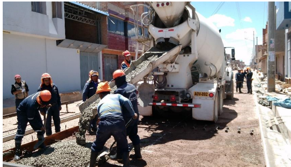
Figura 50 : Descarga de Concreto premezclado de Manera Directa, en obra Fuente: Fotografía Propia.
