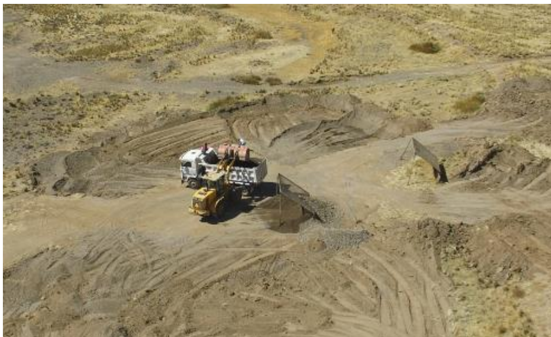
Figura 27 : Carguío de Hormigón a Volquetes – Cantera Cutimbo. Fuente: Elaboración Propia
