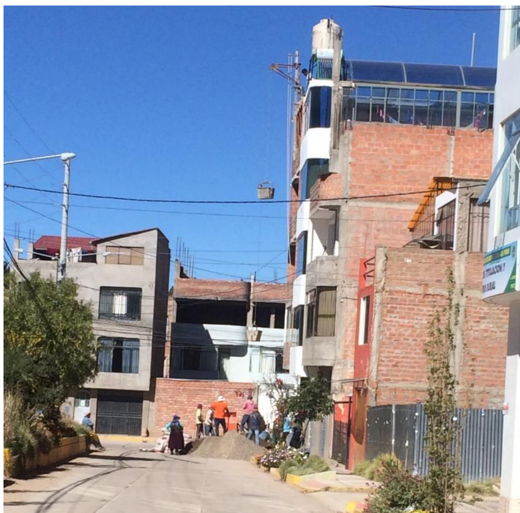
Figura 59 : Uso de winche para transporte y colocación de concreto “In Situ”
