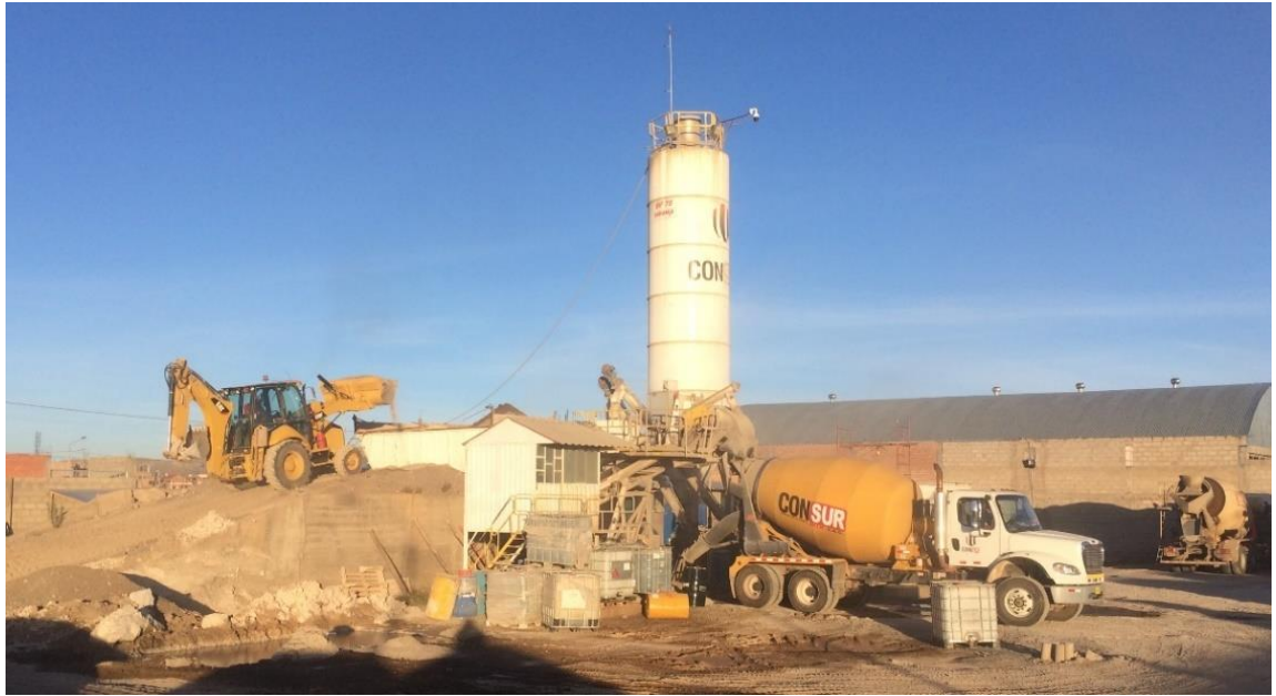
Figura 44 : Retroexcavadora para carguío de agregados – ConSurMix S.A.C.
