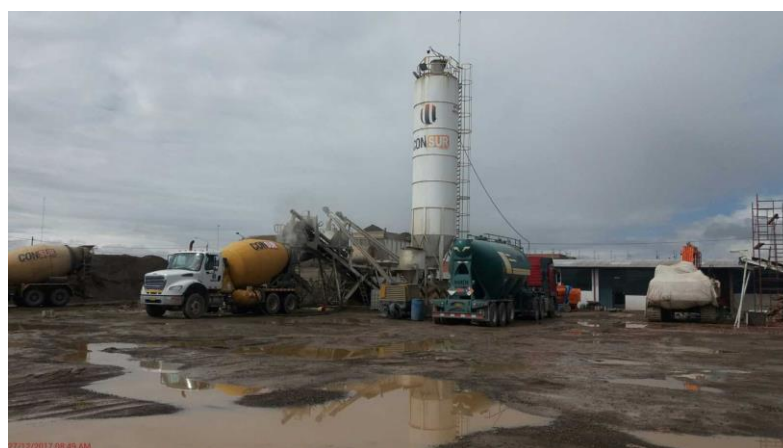
Figura 36 : Planta dosificadora – ConSurMix S.A.C. Fuente: Elaboración propia
