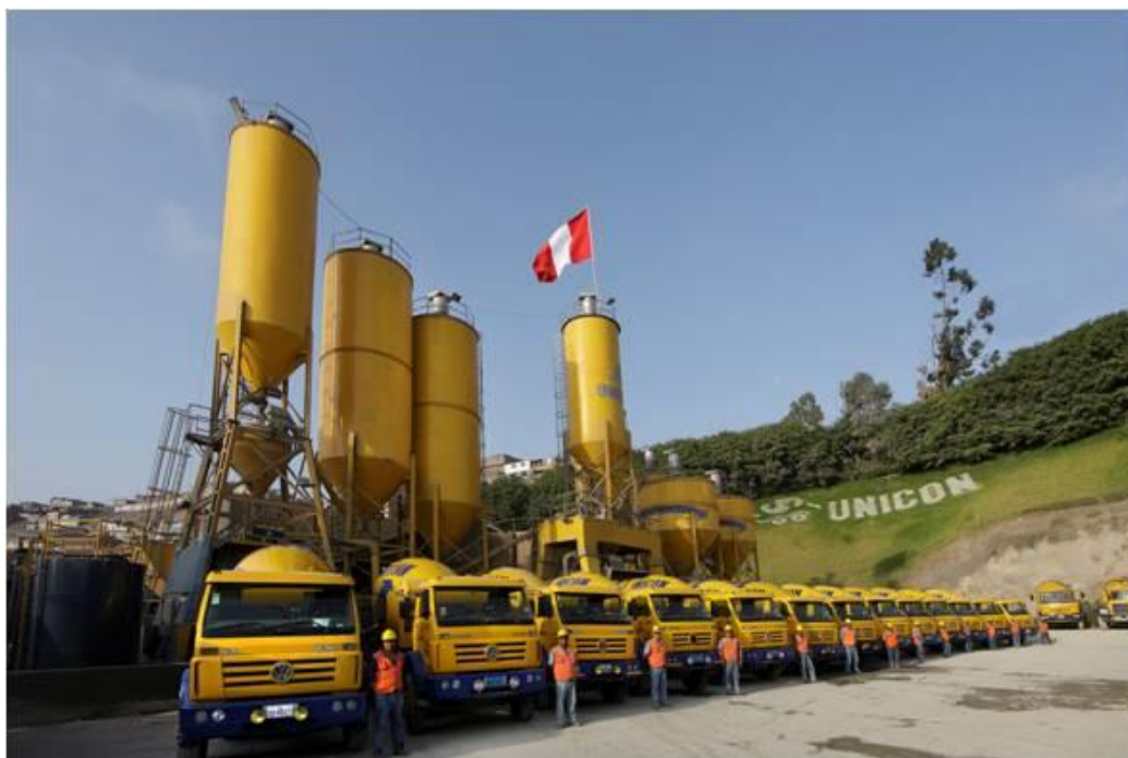
Figura 06 : Planta de Concreto UNICON.
