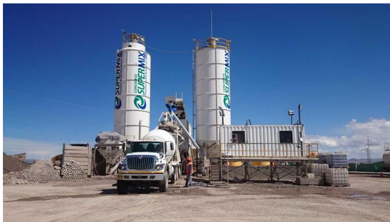
Figura 35 : Planta Dosificadora – Concretos SuperMix S.A. Fuente: Elaboración propia.
