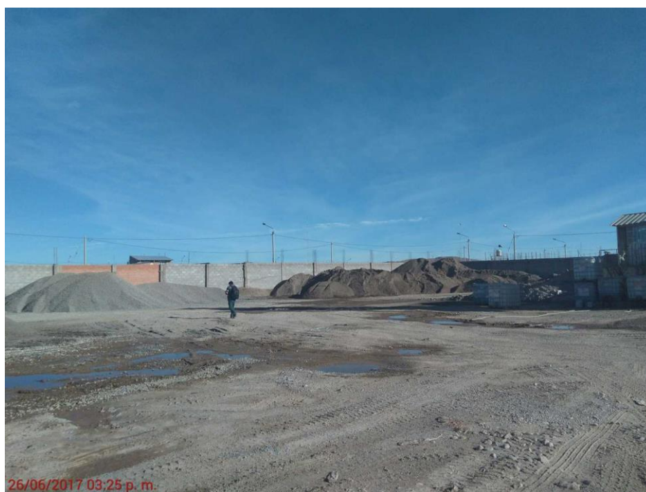
Figura 41 : Acopio de Agregados en Planta Dosificadora – ConSurMix S.A.C.
