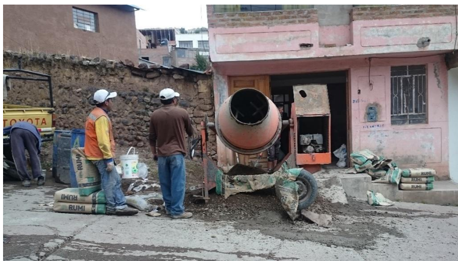
Figura 57 : Mezclado con ayuda de equipo mecánico Fuente: Elaboración Propia
