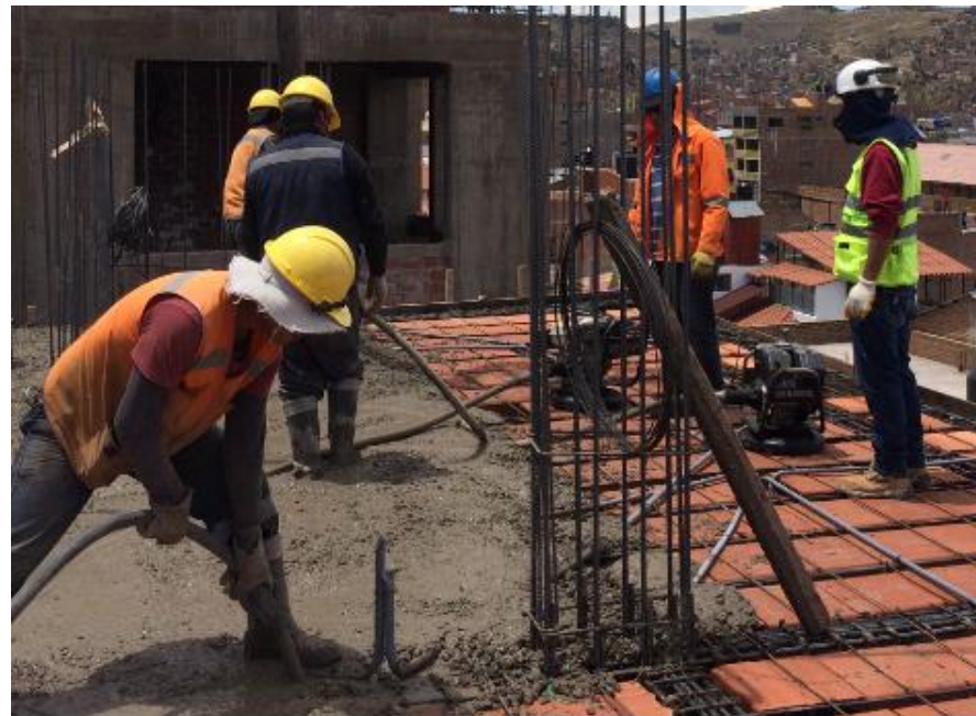
Figura 20 : Uso de vibradora para compactar el concreto Fuente: Elaboración propia
