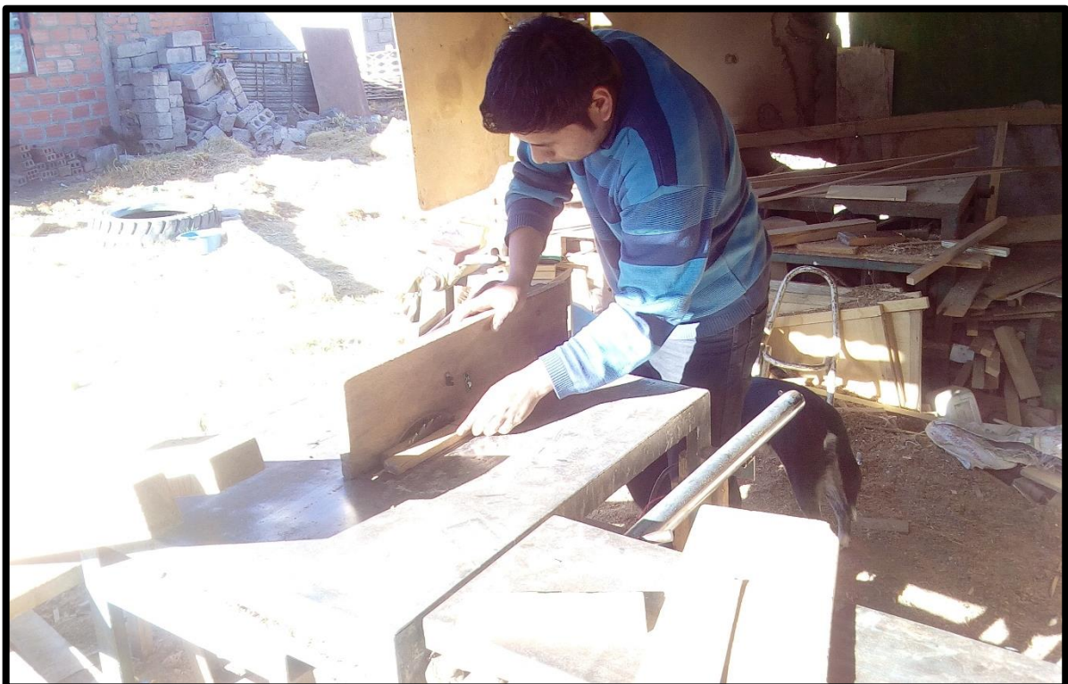
Personal de la empresa hizo uso de la cierra, con el sistema de seguridad implementado.
