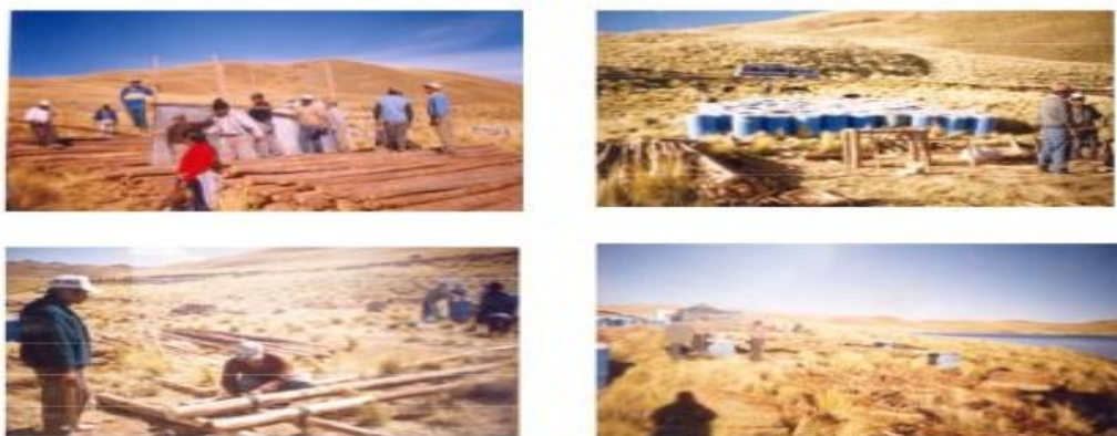
CONSTRUCCIÓN DE LA ESTRUCTURA RIGIDA
