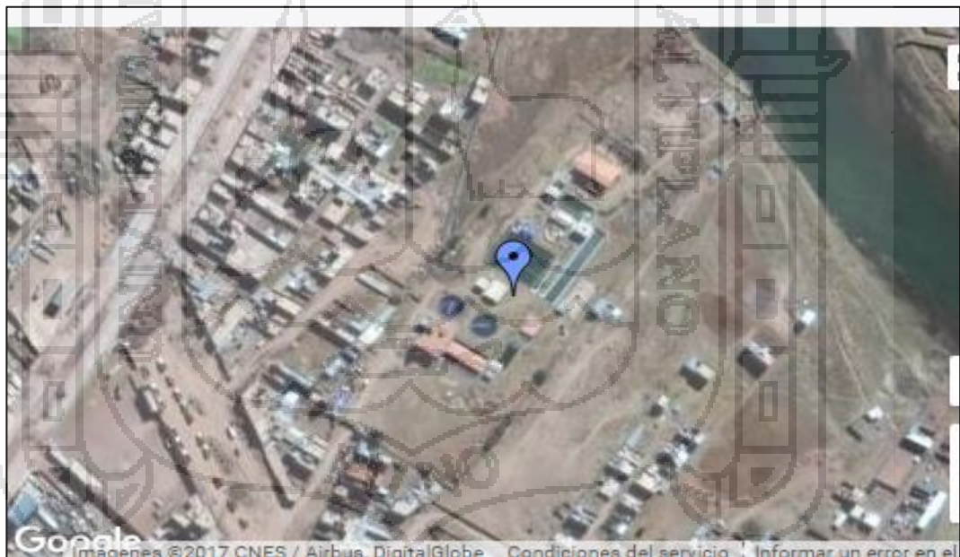
Figura 13. Vista satelital de la Planta de Tratamiento
