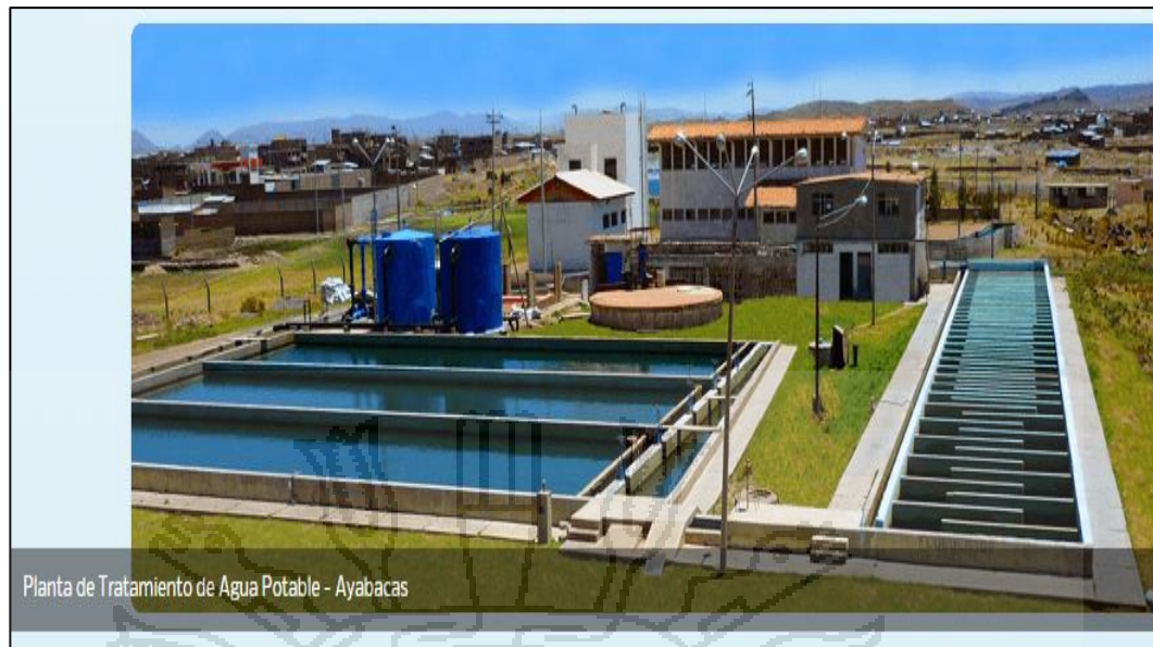
Figura 14. Planta de Tratamiento de Agua Potable
