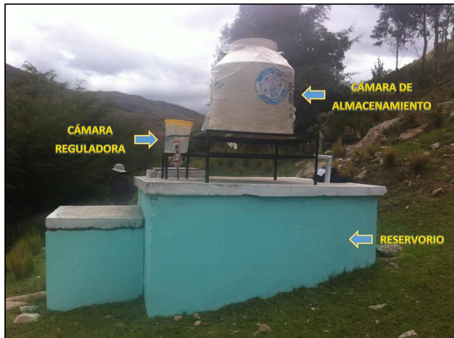
**Figura N° 2 : Identificación de partes de la cloración por goteo**
