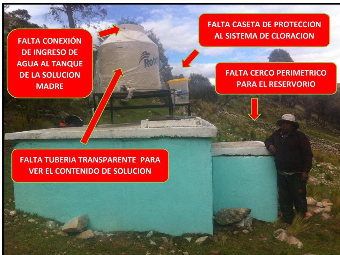
Figura 2.2: Deficiencias del actual sistema de cloración
