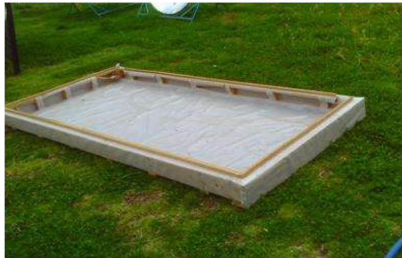
Figura 13. Construida la caja se pasó a colocar el aislante térmico (lana de vidrio de 6.5cm de espesor).
