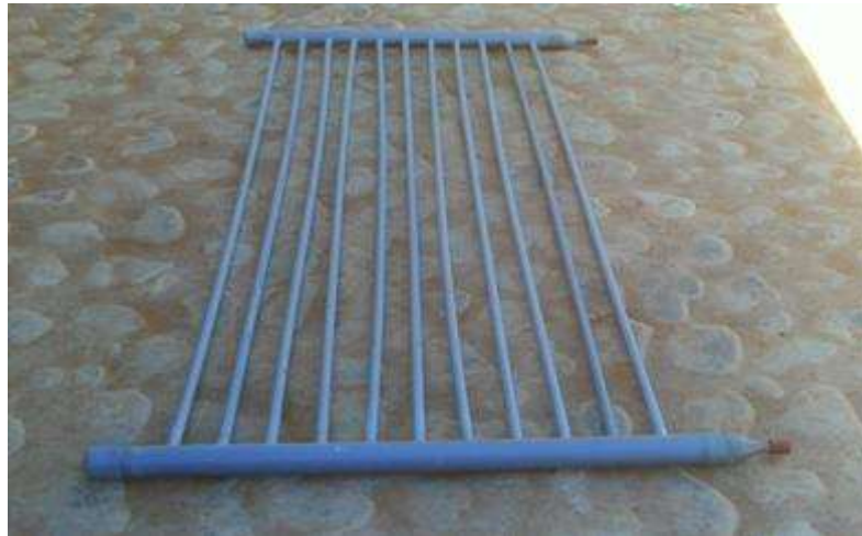
Figura 8. Armado de los tubos en el piso con orificio y pegados
