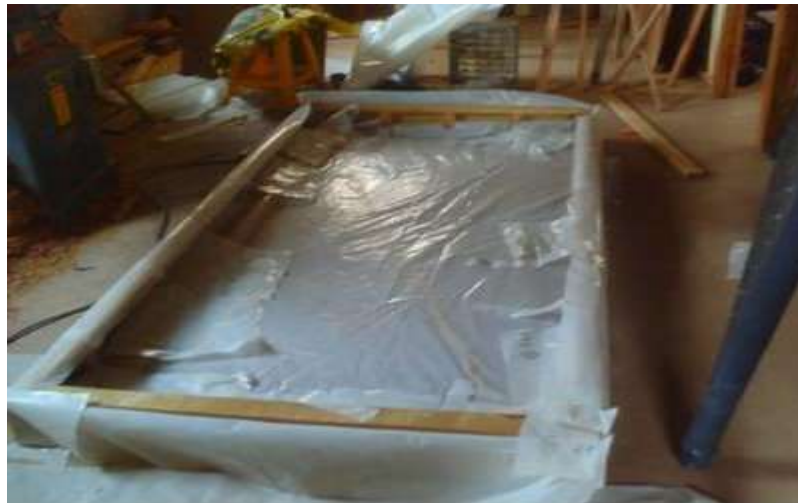
Figura 10. Recubierto con plástico del armazón de tubos
