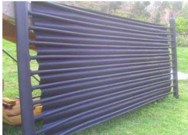
Figura 9. Armado de los tubos en el lugar señalado para su operatividad
