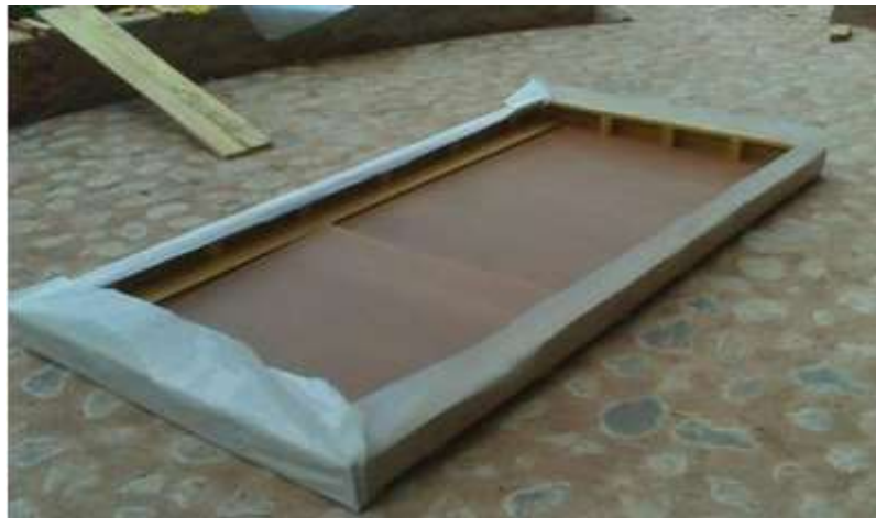
Figura 12. Nivelación del conjunto de armado de tubos recubiertos sobre el piso
