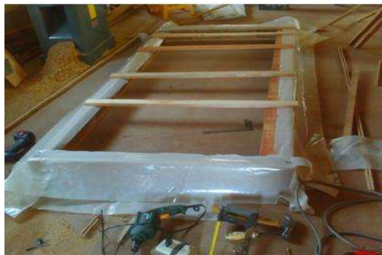
Figura 11. Fijación con listones de la parte superior del armado de tubos
