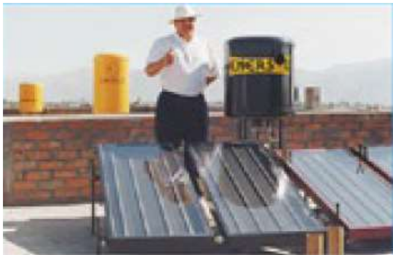
Figura 16. Instalación de las termas solares en domicilio
