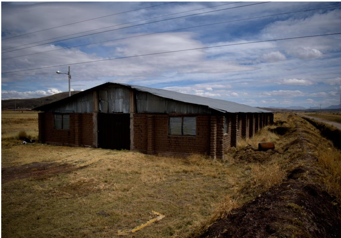
Figura 10. Vista frontal de uno de los almacenes de la EEA a la derecha se nota la carretera antigua a Sillustani, 2017.
