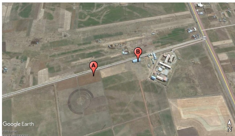
Figura 2. Imagen satelital de la Estación Experimental Zonal Illpa Puno – INIAA, A) Área con cultivo y B) Área sin cultivo. Obtenida de Google Earth Pro Ver. 7.1.8.3036.
