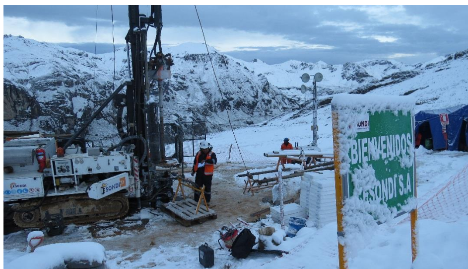
Foto 4; Prueba de permeabilidad durante la perforación, método Lefranc Carga constante Pz-04.
