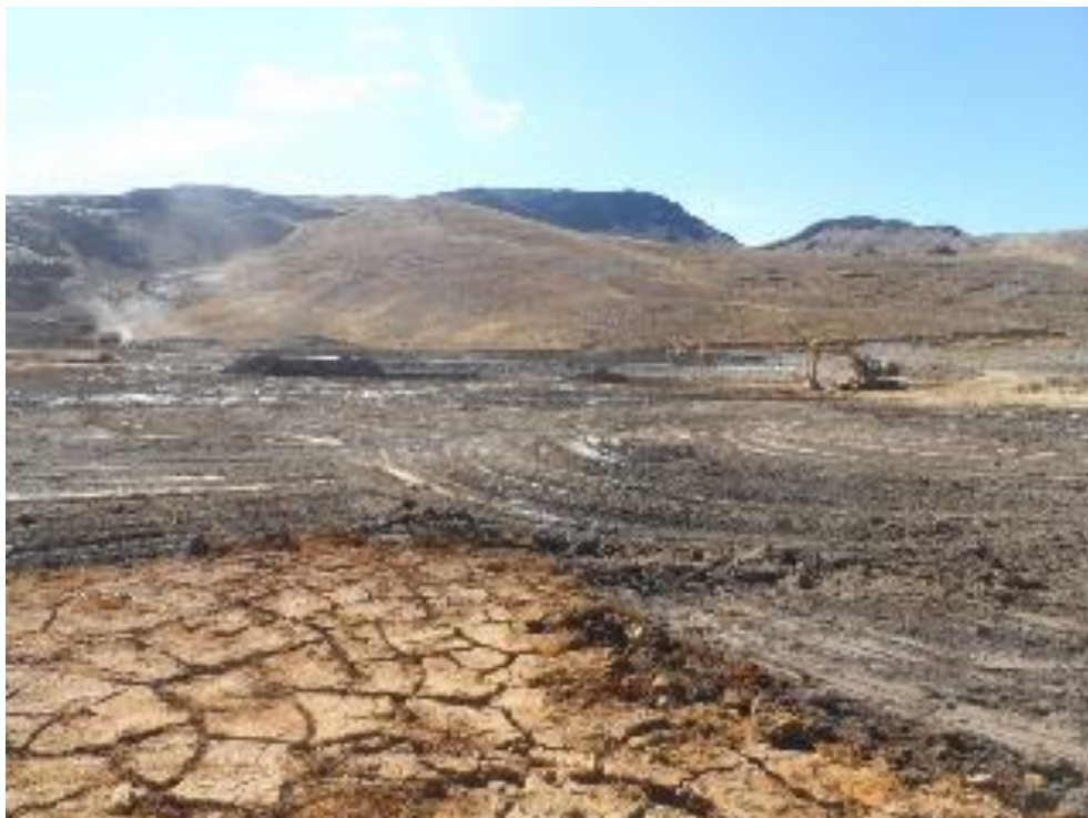
Excavación de las riberas de la laguna Choquene.
