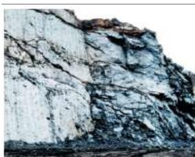
Pequeñas voladuras en taludes de ingeniería civil dan lugar a pequeños daños al macizo rocoso, particularmente si se usan voladuras de contorno como se muestra en el lado izquierdo de la fotografía. Sin embargo, la liberación de tensiones resulta en alguna alteración.
