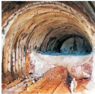
Excavación mecánica o manual en macizos rocosos de mala calidad (sin voladuras) con una alteración mínima en el macizo rocoso.
