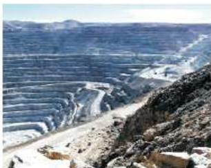
Los taludes en las grandes minas a cielo abierto sufren alteraciones significativas debido a las grandes voladuras de producción y también debido a la relajación de tensiones al retirar el estéril de recubrimiento.
