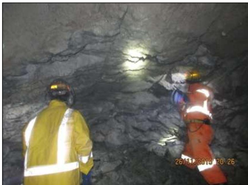
**C.3 Resultado de voladura de contorno con explosivo Famecorte E-20 en los hastiales del Bp 179**
