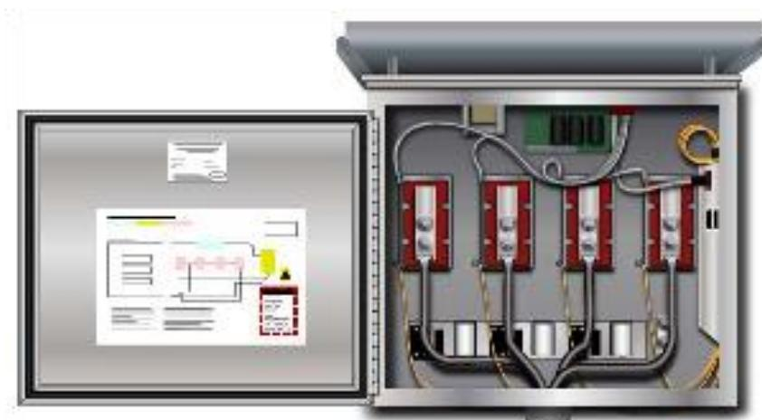
Figura 2.8: Unidad de Modulación de Salida (OMU).
