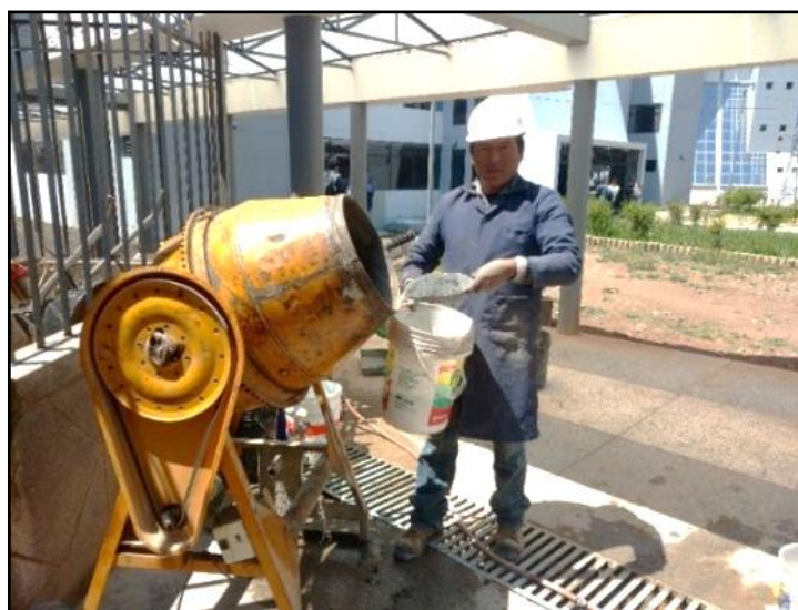
Figura 3.5. Mezclado de concreto.
