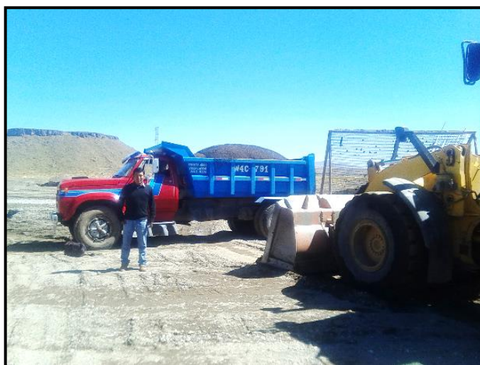
Figura 3.1. Traslado de material de la cantera Cutimbo.
