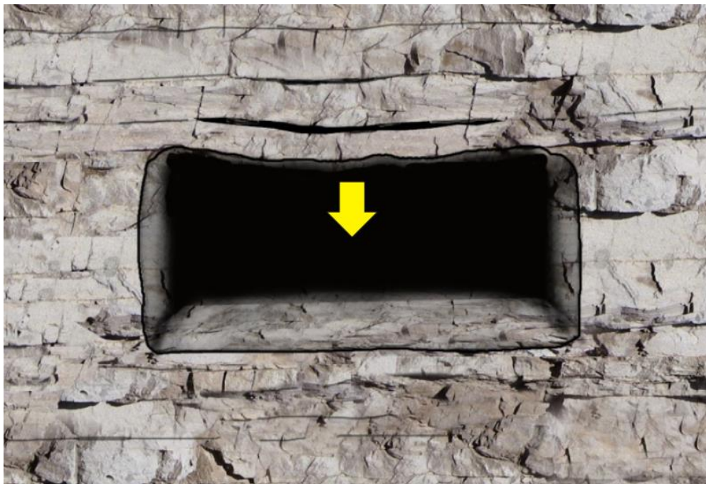
Figura 25: Separación o despegue de los estratos sub horizontales, flexión y caída hacia el vacío minado.
