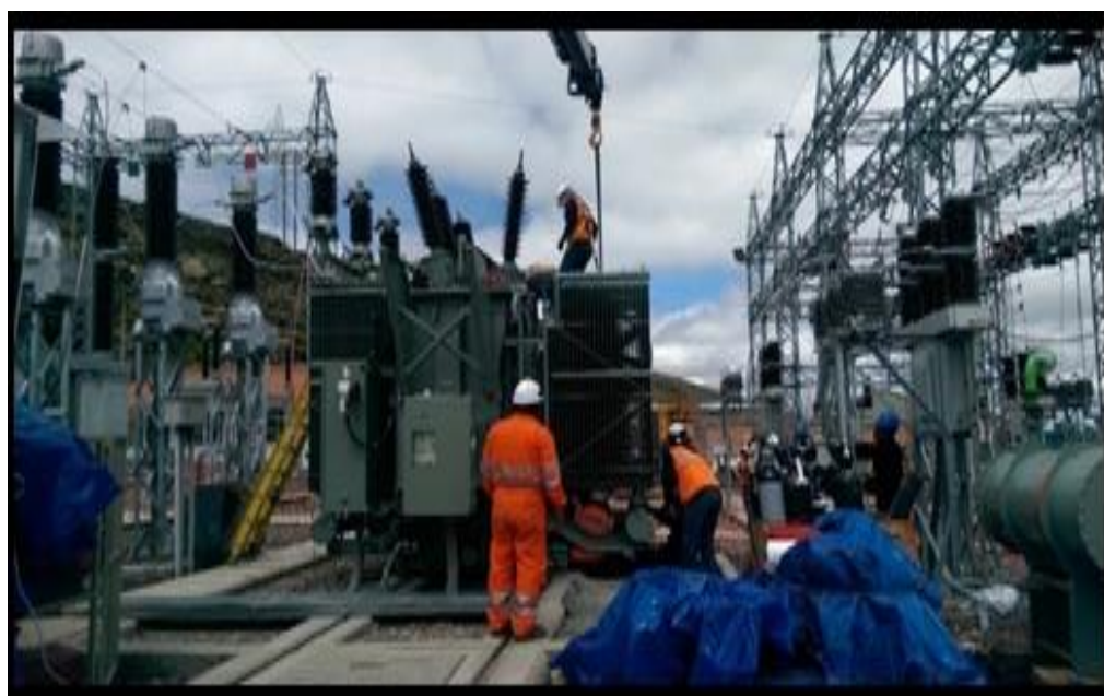
Figura 2.4: Pruebas finales un transformador de 15MVA. ANANEA
