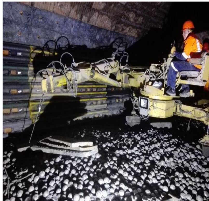
Figura N° 20. Retiro de forros desgastados con manipulador de corazas Fuente: Elaboración propia
