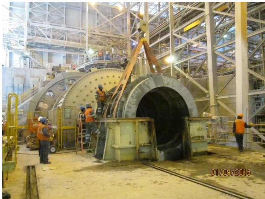
Figura N° 16. Desmontaje de Trommel Molino Fuller Fuente: Elaboración propia
