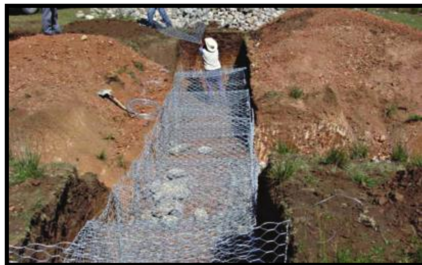
Figura 15: Colocación de gaviones.
