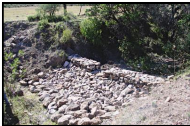
Figura 18: Dique de piedra acomodada.
