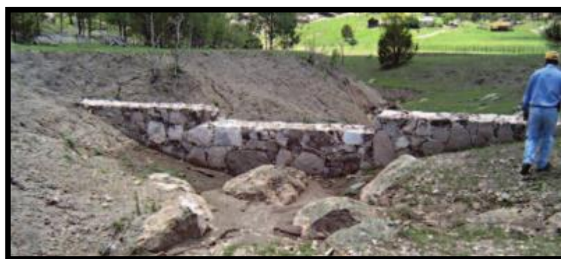
Figura 20: Dique de piedra acomodada, construida con roca caliza.
