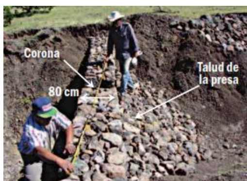
Figura 22: Vista lateral de un dique acomodada.
