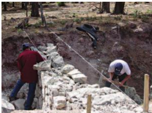
Figura 25: Conformación del empotramiento y la base.
