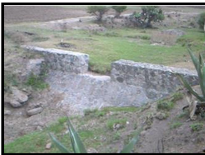
Figura 37: Dique de mampostería hidráulica o disipador de energía.
