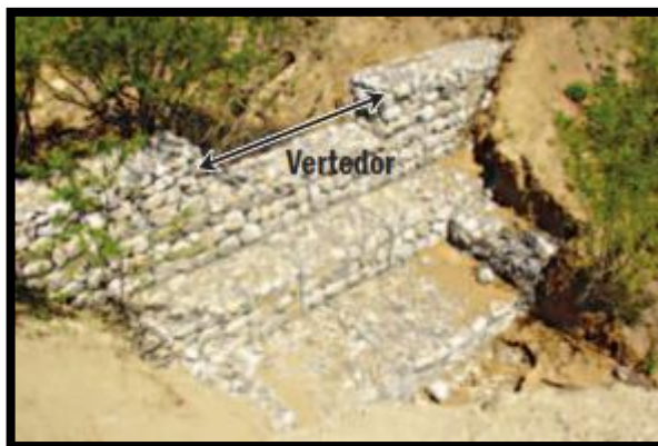
Figura 17: Vertedor de un dique de gaviones.
