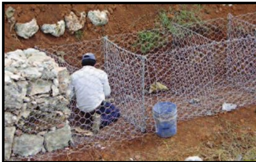
Figura 16: Gaviones en la zanja.
