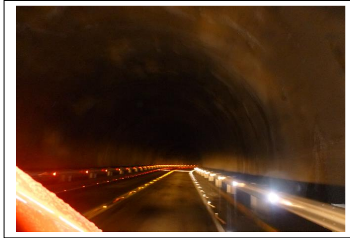
Figura 16. Túnel “El Carmen”
