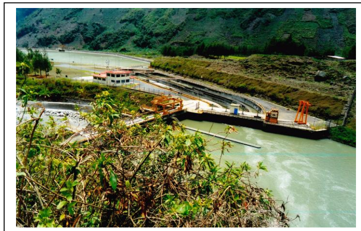
Figura 14. Infraestructura de la hidroeléctrica San Gabán
