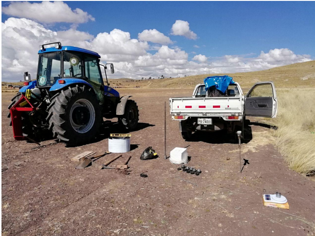
Figura 10. Maquinaria, materiales y equipos para la ejecución
