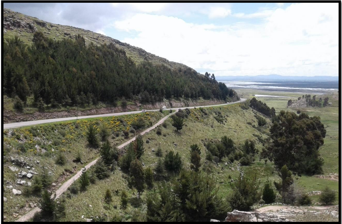
Fotografía 11: Vía principal Puno-Juliaca.
