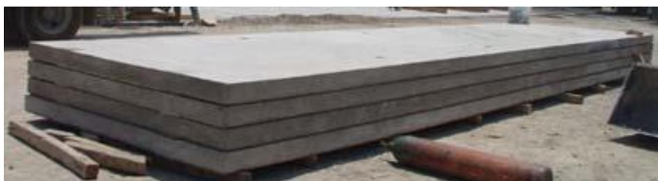
*FIGURA 81: MUROS PREFABRICADOS*
