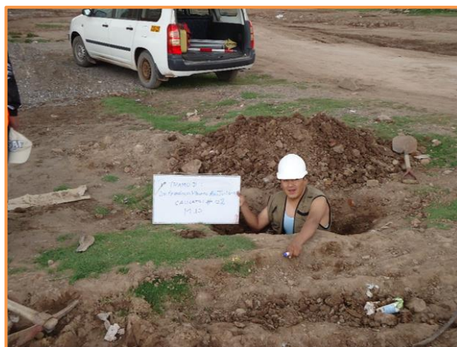
Figura 27: Vista de excavación de calicata N° 2
