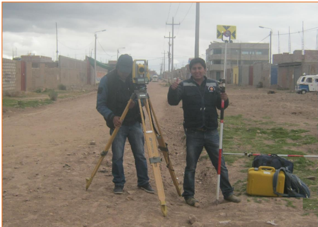
Figura 8: Vista del levantamiento topográfico con Estación Total en la avenida Perú
