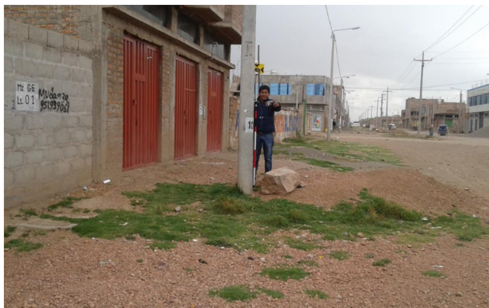
Figura 10: Vista de la toma de datos de postes en el levantamiento topográfico en la avenida Perú
