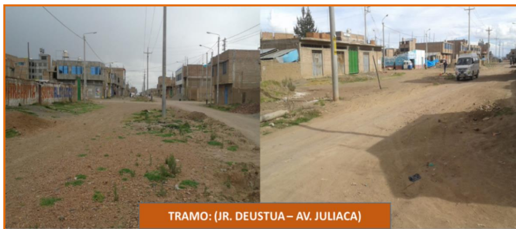
Figura 4: Vista Actual de la Vía Progresiva (0+640 – 0+953)
