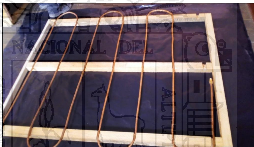
Figura 61. Suelo Radiante con tuberías de Cu 3/8".
