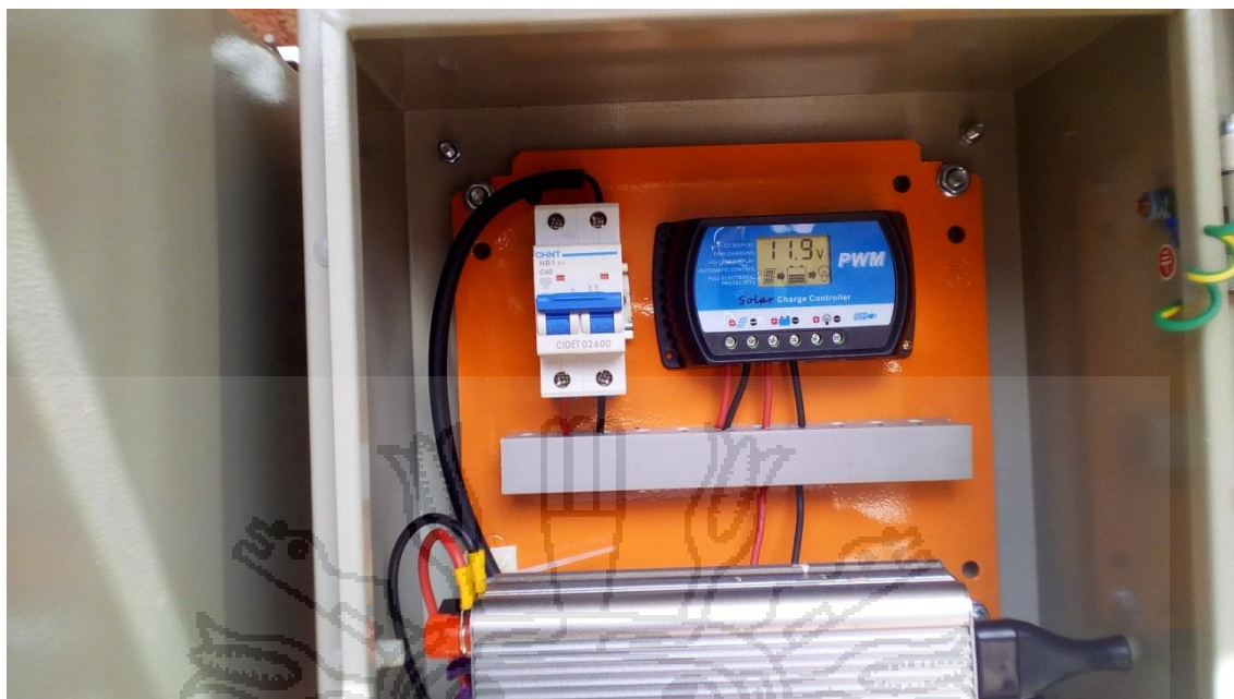
Instalando el tablero de Control del Módulo Fotovoltaico y control de la Bomba.
