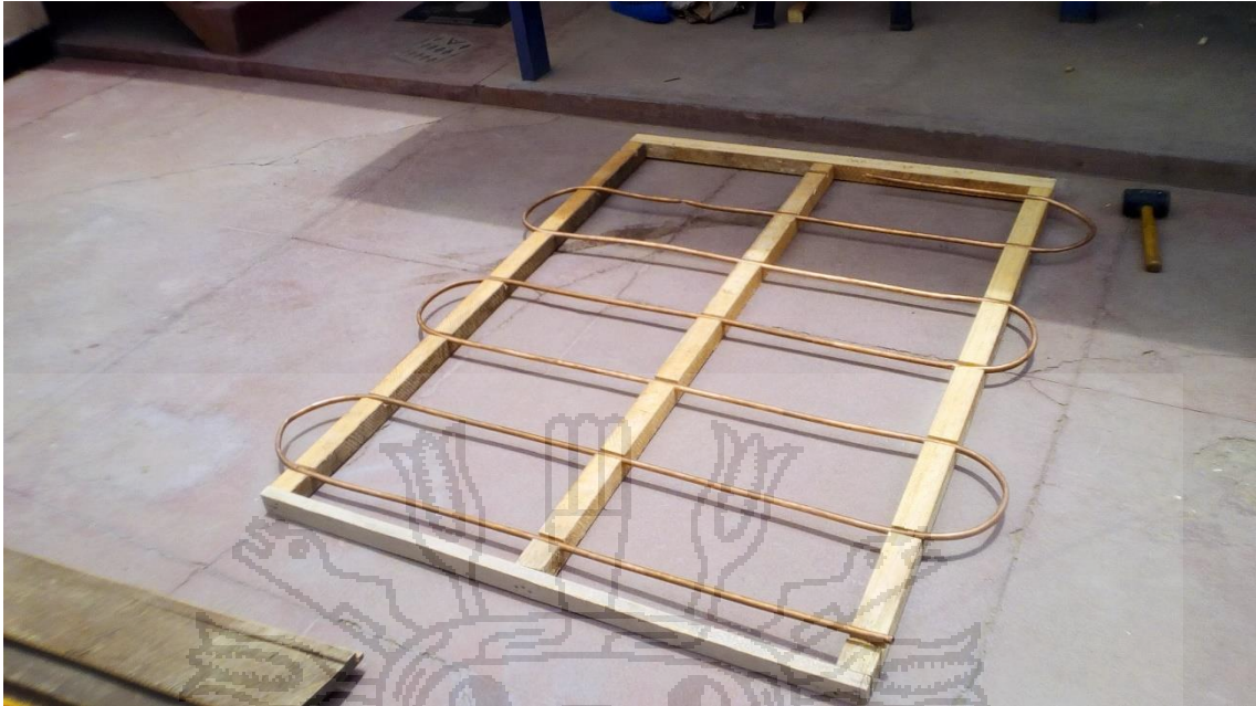
Colocando la tubería de Cu a la estructura de madera.
