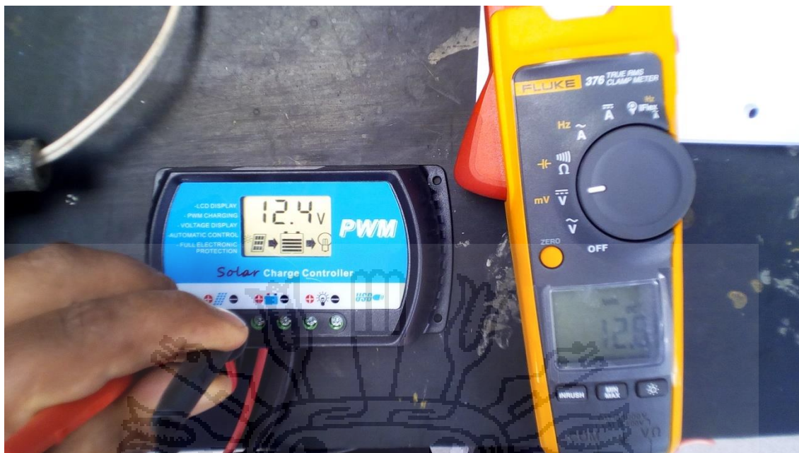
Verificando el Regulador de carga con el Panel Solar Fotovoltaico.
