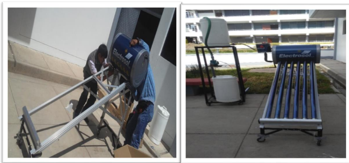
Ensamblado del equipo proceso de oxidación (POA)
