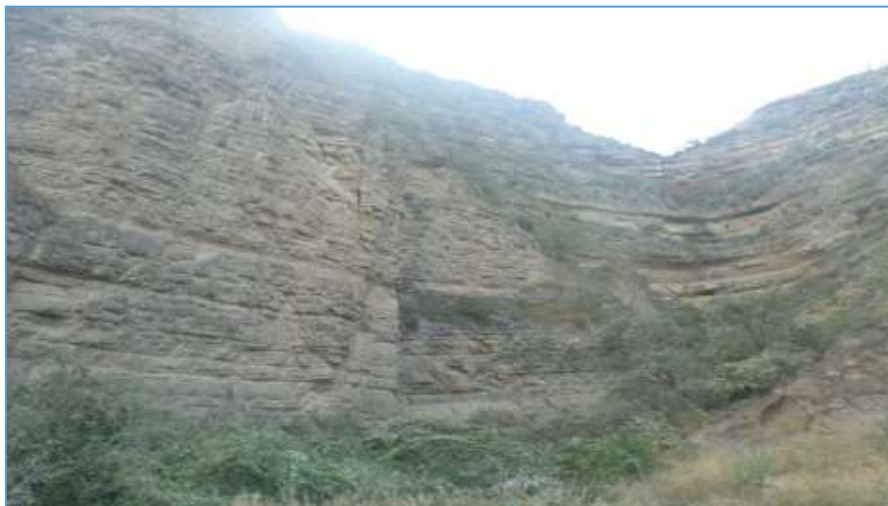
Foto N° 9 : Afloramiento de calizas Fm. Pariatambo (Ks-p). Estratos delgados característicos, planas y paralelas intercaladas con limoarcillitas.
