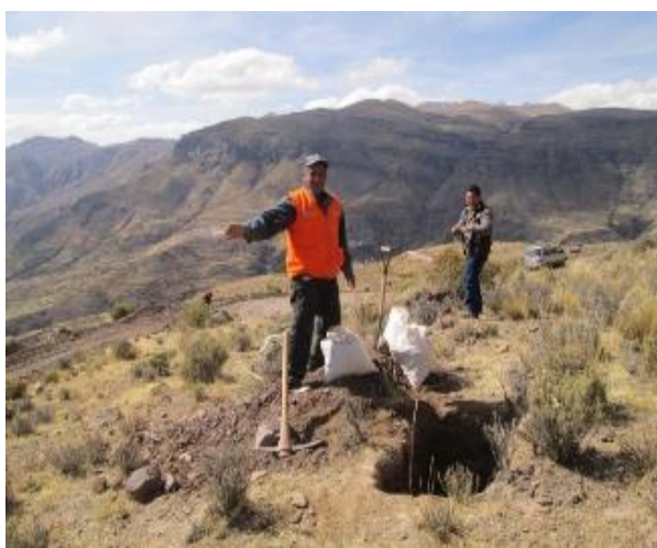
Imagen 33 APERTURA DE CALICATAS
