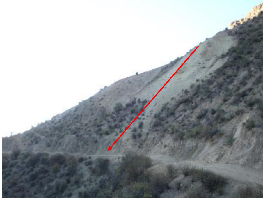
Imagen 11 SE APRECIA EL DESLIZAMIENTO TIPO FLUJO RAPIDO
