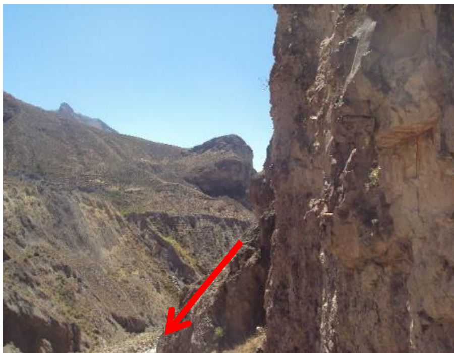
Imagen 16 OTRO ANGULO DE TALUD CERRO PUCARA
