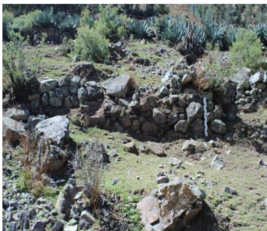
Figura 12. Sección de muro de andén ubicado en el sitio de Kerkehua. Fuente: Registro tomado en el trabajo de campo, 2016.
