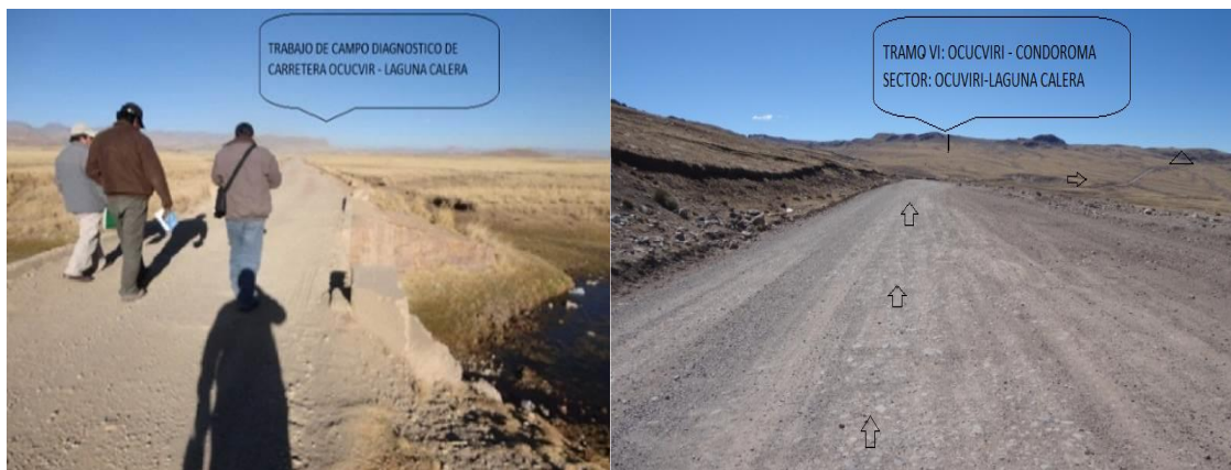
FIGURA 15: INSPECCIÓN VIA OCUCVIRI - LAGUNA CALERA
