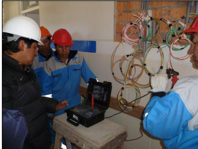
Fig. 3.3.: Medición de aislamiento y continuidad eléctrica
