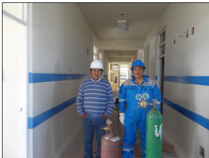
Fig. 3.4.: Verificación de fuga en los sistemas mecánicos gases medicinales
