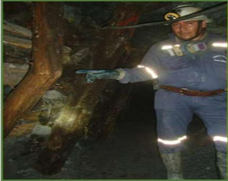
**Foto N° 07:** se observa cómo se trabajaba con los cuadros deteriorados, fuente de peligro y riesgo.
