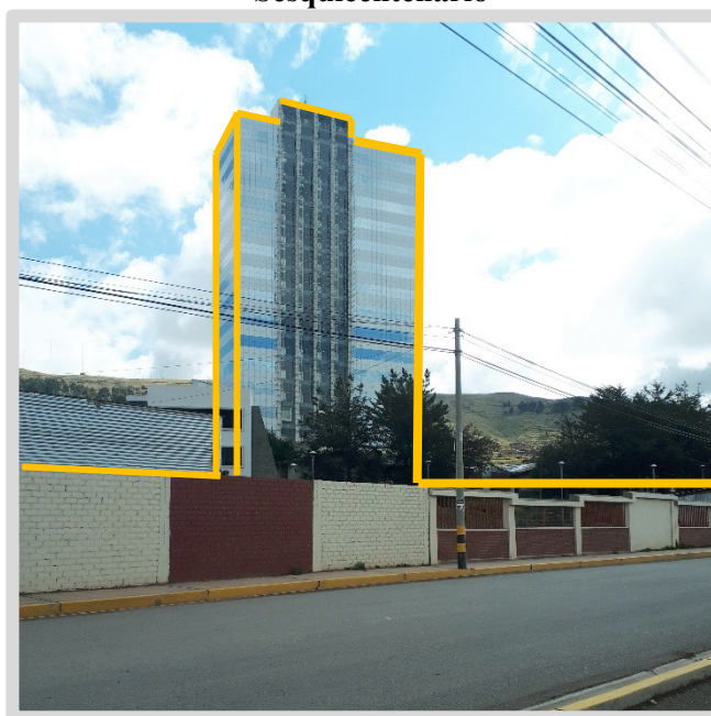
Figura 136. Edificio 15 pisos una puno, Av. Sesquicentenario
