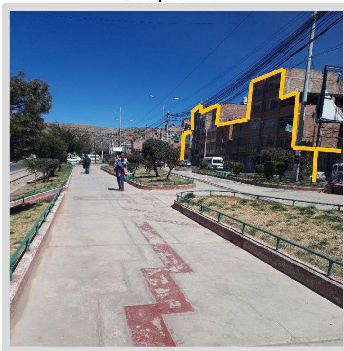
Figura 133. Estadio en construcción UNA – PUNO, Av. sesquicentenario
