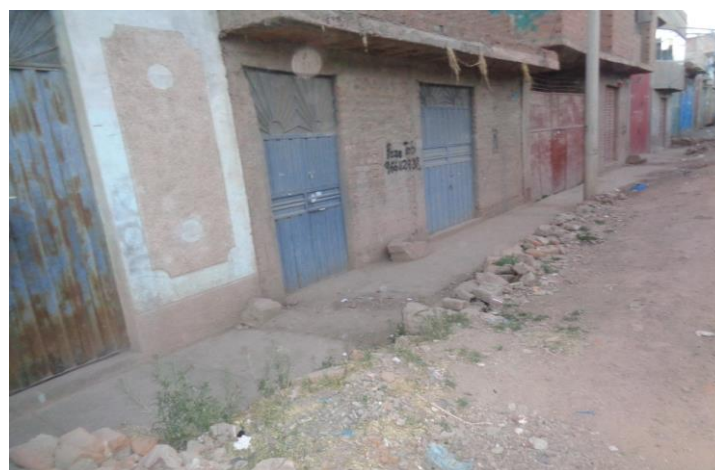
Figura N° 4. Tratamiento de lastrado sobre el nivel de viviendas.
