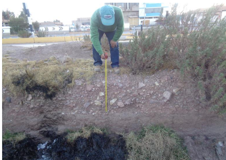
Figura N° 2. Lastrado de aproximadamente 60 cm.
