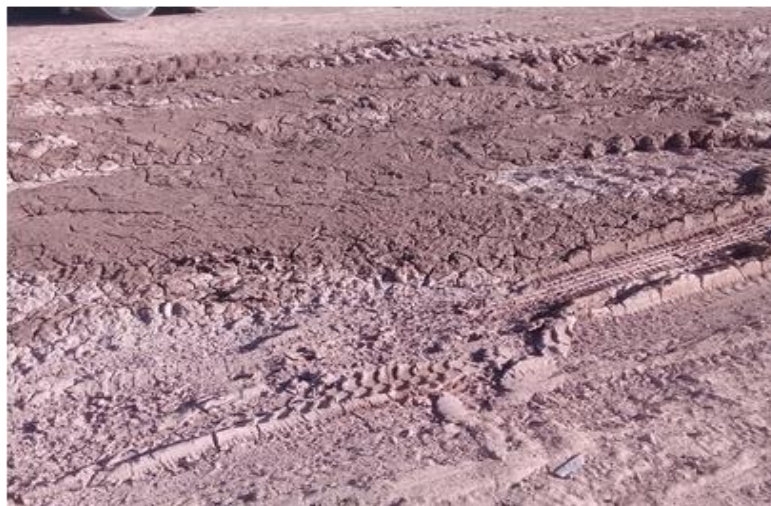
Figura N° 18. Material residual produciendo inundación y lodos.
