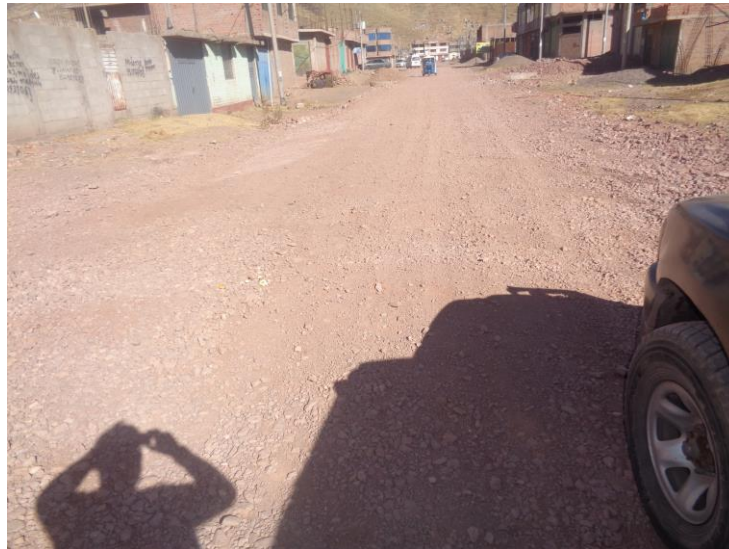
Figura N° 12. Lastrado reciente de arteria vial.
