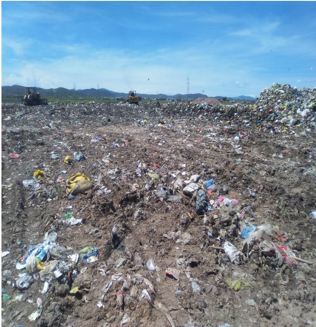
Figura A.4: de Esther Paucar. (botadero de basura Chilla. 2017). En la fotografía se observa las maquinarias haciendo el compacto de la basura q es acopiada.
