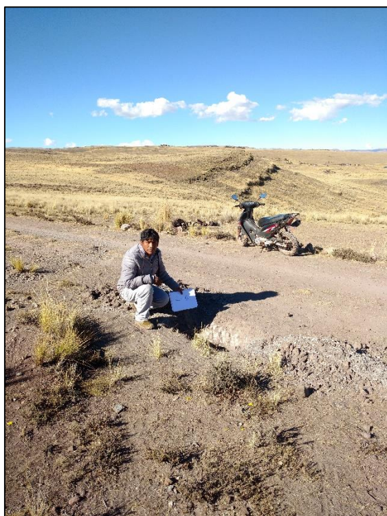
FOTO N° 27: EXCAVACION DE CALICATA
