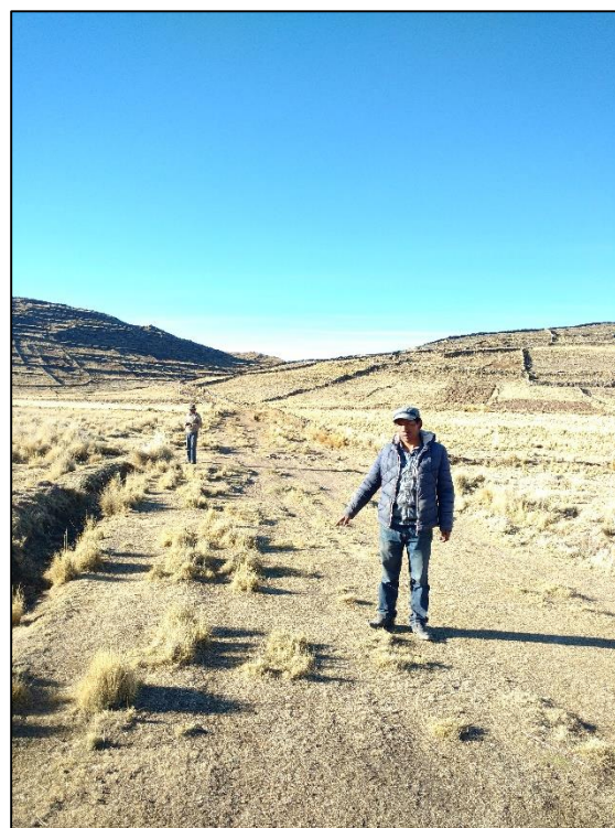
FOTO N° 20: SE OBSERVA PASTISALES SOBRE LA PLATAFORMA DE LA VIA
