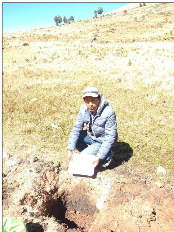
FOTO N° 17: SE OBSERVA TAPADO DE CALICATA
