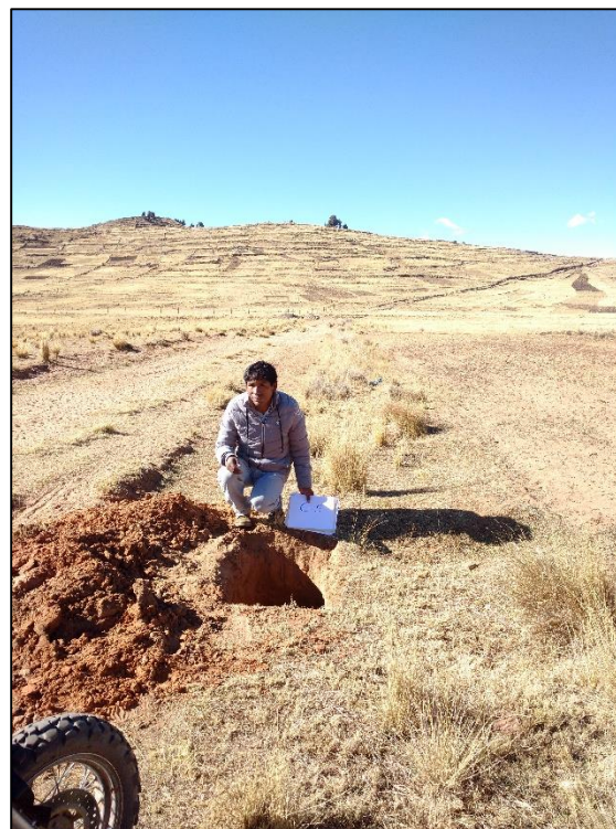
FOTO N° 24: EXCAVACION DE CALICATA A UN LADO DE LA VIA
