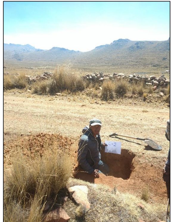
FOTO N° 16: CALICATA C-2 PARA EXPLORACION DE SUBRASANTE
