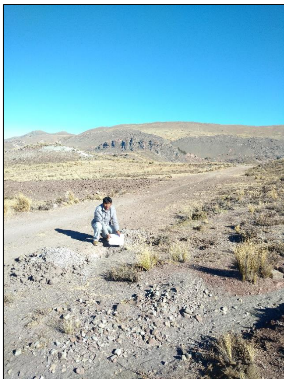
FOTO N° 25: EXCAVACION DE CALICATA N° 6 EN LA VIA
