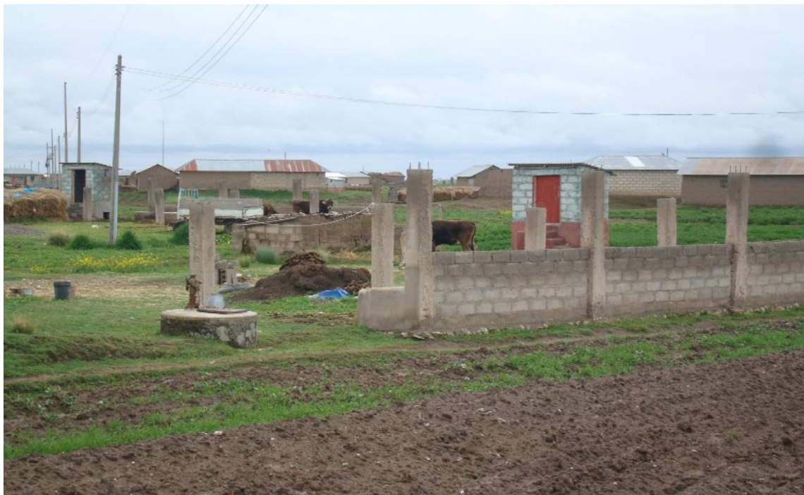
Figura 11. Pozo de agua familiar del centro poblado Accaso, distrito Pilcuyo.
