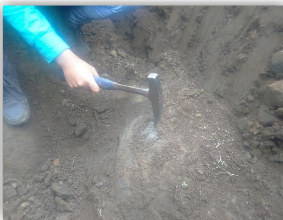
Figura 53: Verificación de la calidad de roca encontrada en el fondo de calicata N° 4 utilizando martillo de geólogo
