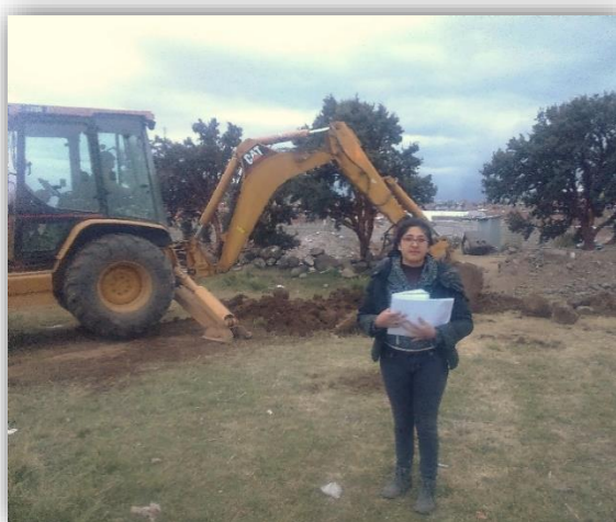
Figura 52: Supervisión y toma de datos en excavación con maquinaria de calicatas planteadas.
