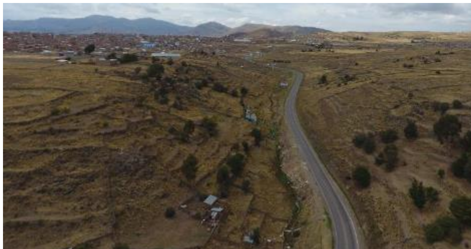
FIGURA 36: Vista aérea de la vía
