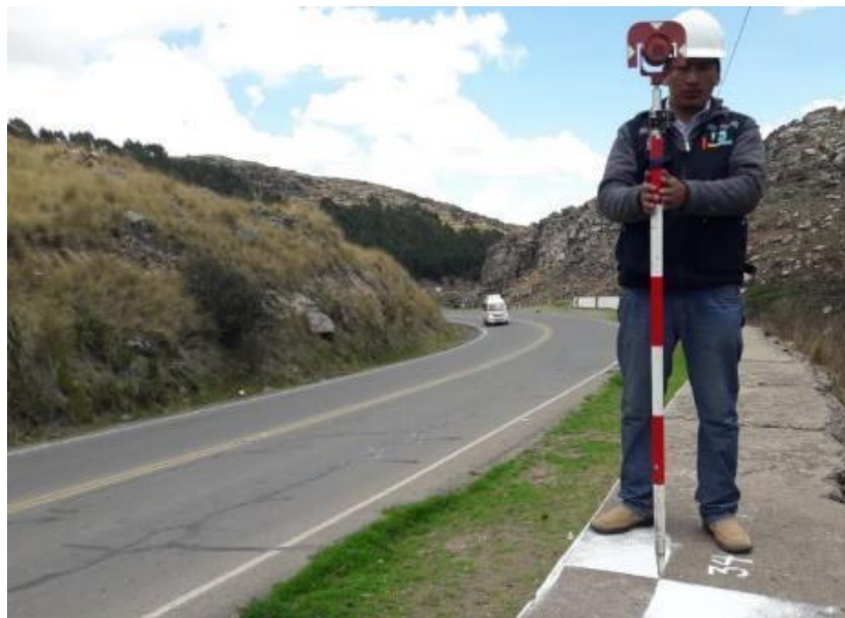
FIGURA 33: Colocación de puntos de control en el tramo
